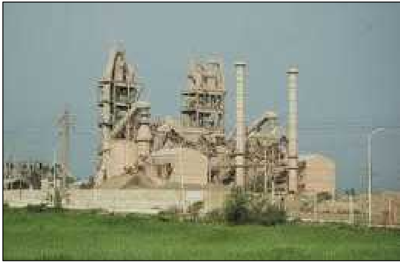
FIG II-19 : Vue d'ensemble de la cimenterie de Chlef.
