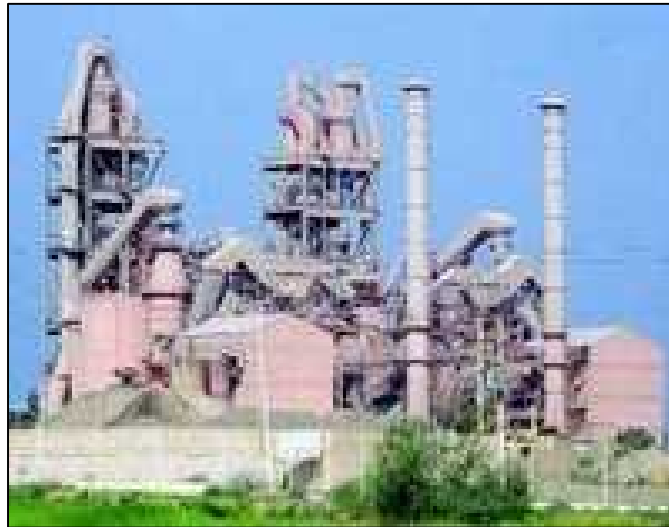
FIG II-28: Vue d'ensemble de la Cimenterie de Hadjar Essoud.
