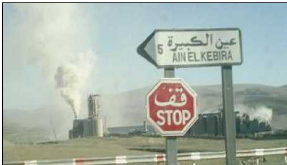
FIG II-4: Vue d'ensemble de la cimenterie d'Ain El Kebira.
