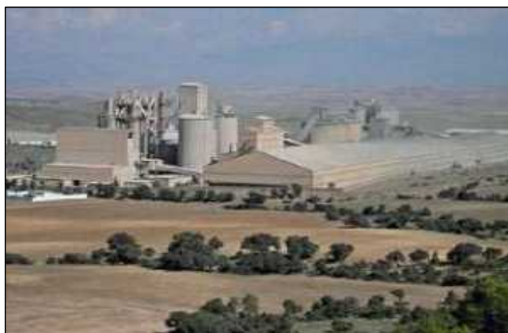
FIGII-33 : Vue d'ensemble de la cimenterie de Sour El Ghozlane.
