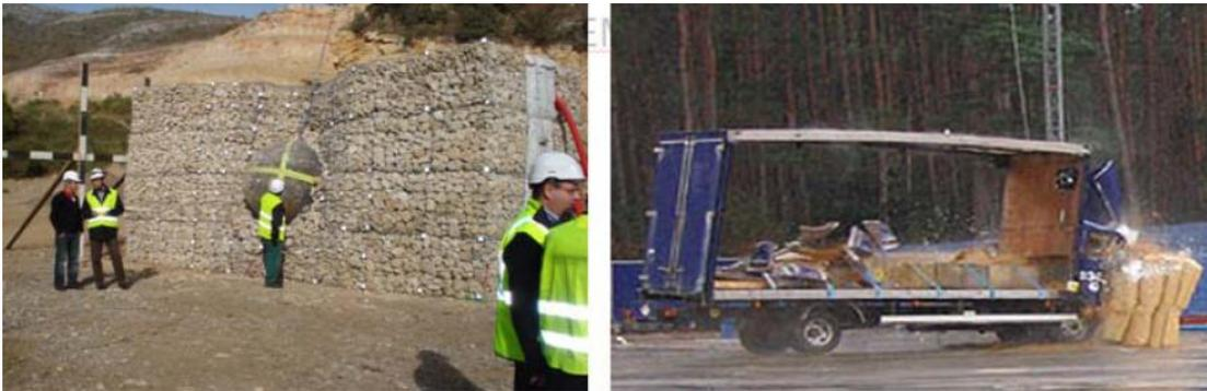
Figure 52 : à droite le procédé Defencell, à gauche merlons à double parement (gabions)
