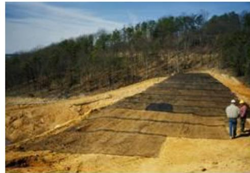
Figure 15 : une nappe géosynthétique pour une construction d'un remblai
