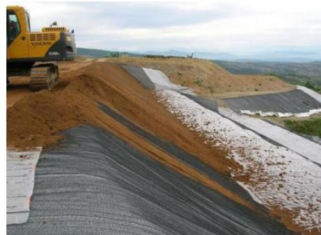
Figure 16 : une nappe géosynthétique dans une construction une pente
