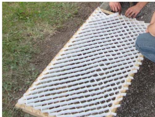
Figure 61 : Mise en place d'une nappe alvéolaire sur le cadre
