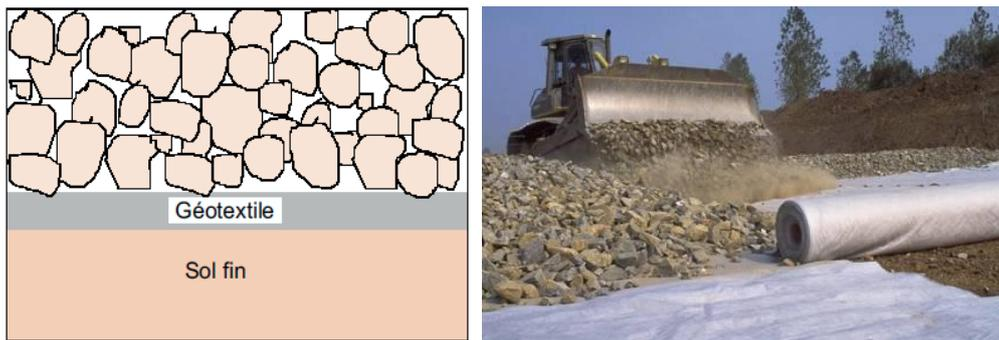
Figure 22 : Séparation des couches par un géotextile
