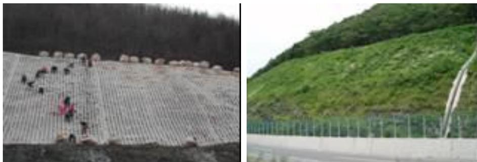
Figure 18 : à gauche contrôle d'érosion sur pente, à droite travaux achevés
