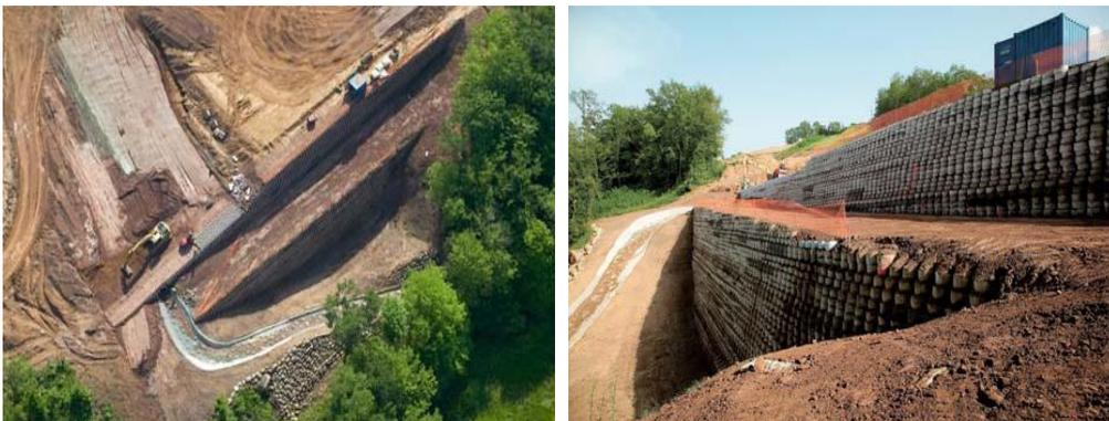
Figure 43 : Soutènement de grande hauteur vue en plan et vue de profil (Lyon – France)
