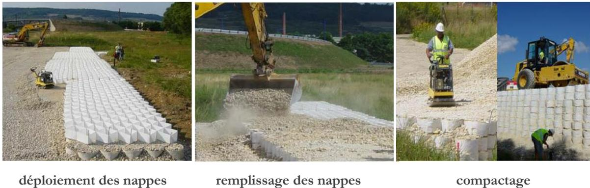
Figure 47 : Etapes de mise en œuvre du procédé M3S
