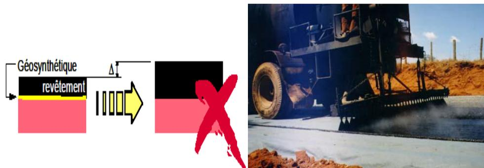
Figure 30 : mise en place revêtement bitumineux
