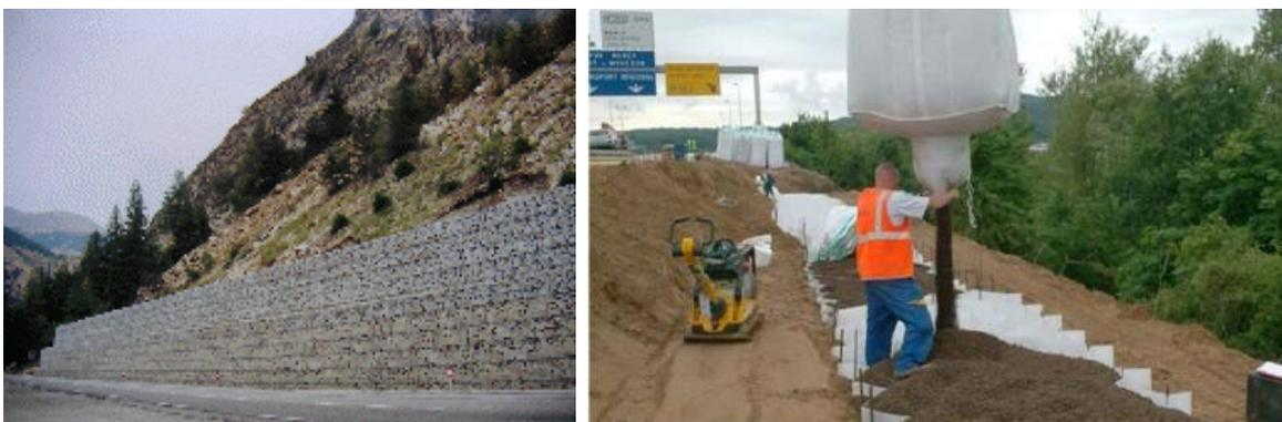
Figure 44 : à droite élargissement de route, à gauche merlon de protection
