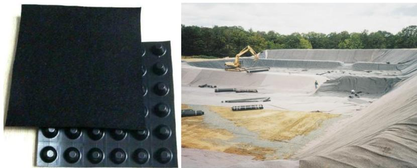
Figure 11 : Géomembrane à gauche leur forme, et à droite leur mise en place
