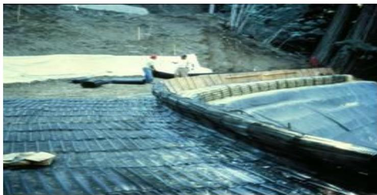
Figure 13 : un renforcement d'une pente par un géosynthétique
