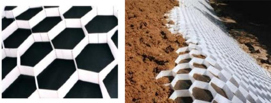
Figure 10 : à gauche la forme d'un géosynthétique alvéolaire, à droite placement d'une nappe
