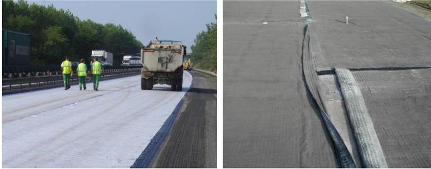
Figure 32 : Mise en place des géosynthétiques dans une construction de route
