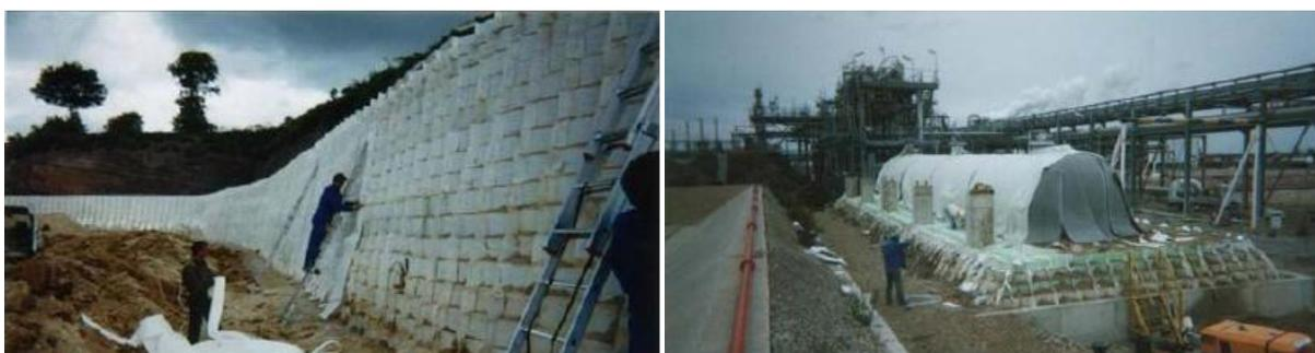
Figure 45 : à droite confinement de cuve, à gauche raidissement de parois
