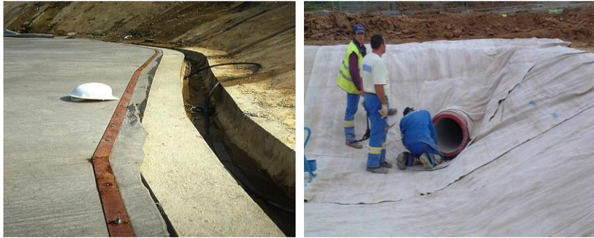
Figure 33 : Mise en place des géosynthétiques
