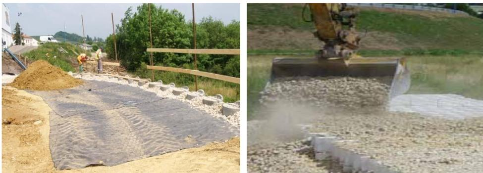
Figure 34 : Mise en place des matériaux sur les géosynthétiques
