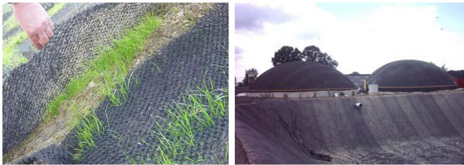
Figure 19 : à gauche végétation à l'aide de géogridde, à droite un bassin couvé par géomembrane
