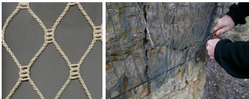
Figure 7 : à gauche un modèle de géofilet, à droite un géofilet dans un merlon
