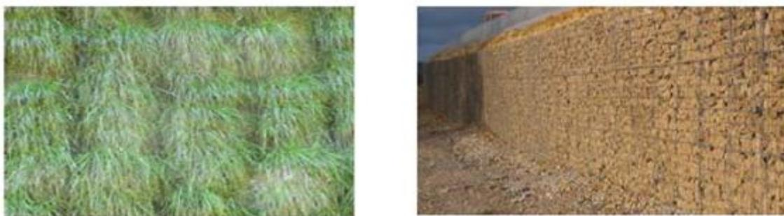
Figure 42 : à droite parement minéral, à gauche parement végétal
