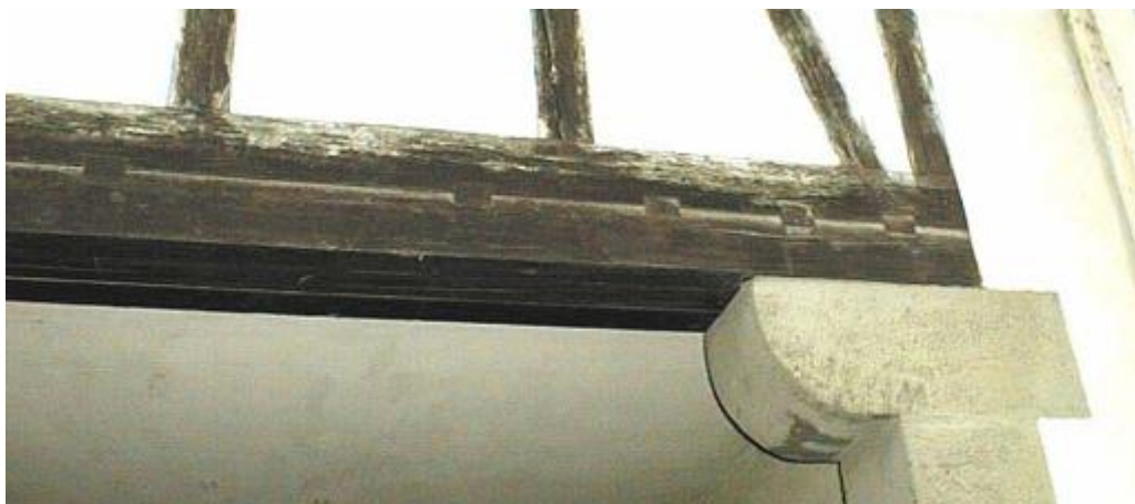
Figure III-4: poutre composée (photo)
