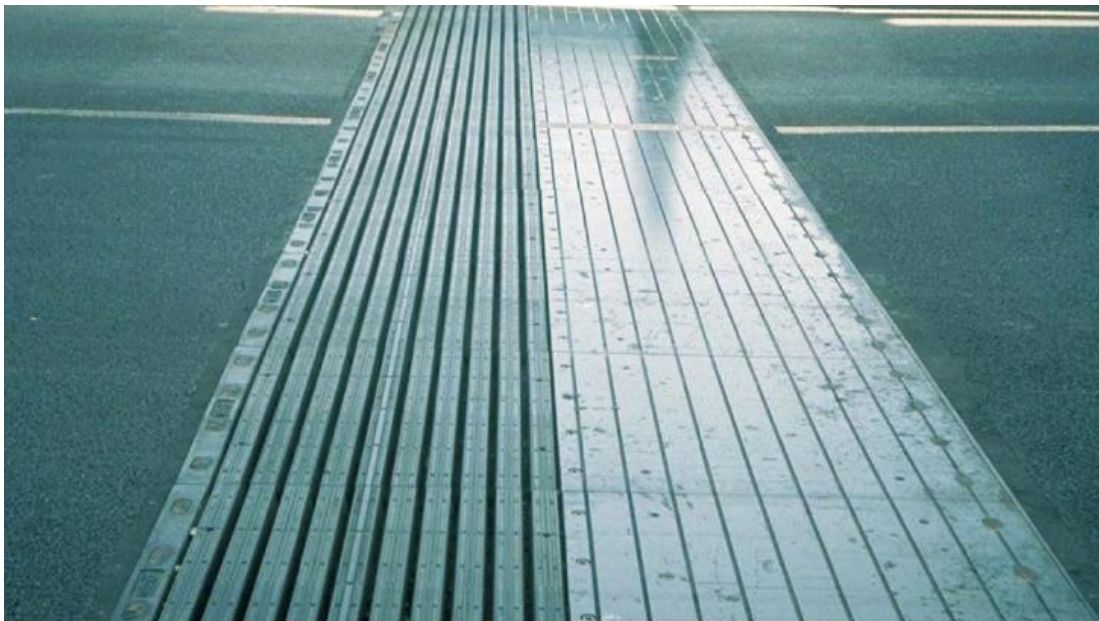
Figure 81. Joint de chaussées TM320 (Algaflex TM)
