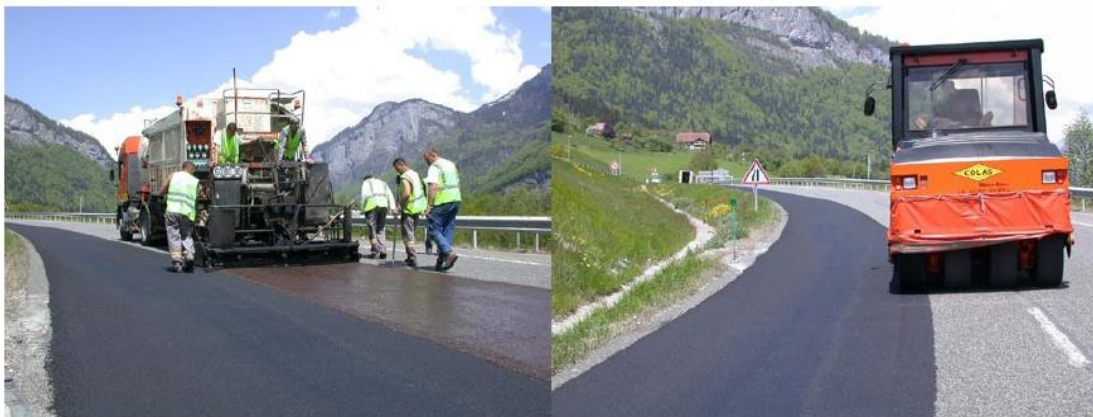
Figure 15 : Mise en œuvre d'une couche d'enrobé à froid
