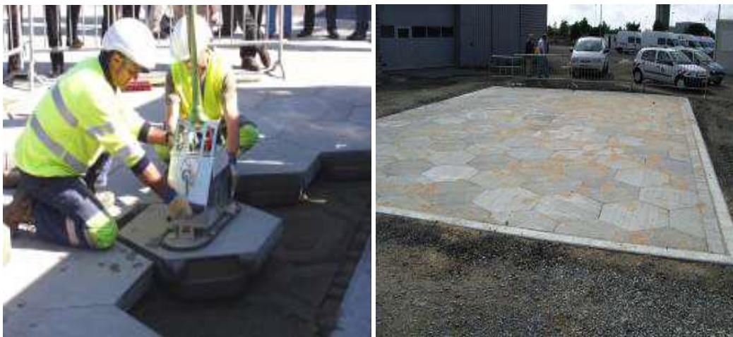
Figure 4 : Dalles hexagonales connectées par "clés" béton, Chantier expérimental Nantes
