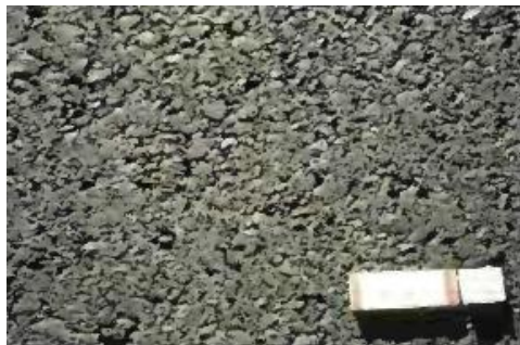
Figure 10 : Revêtement en BBSG
