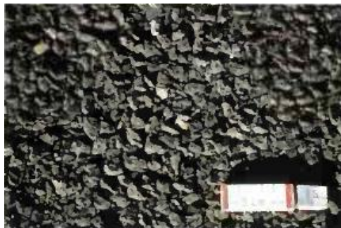
Figure 9 : Photo d'un enduit superficiel
