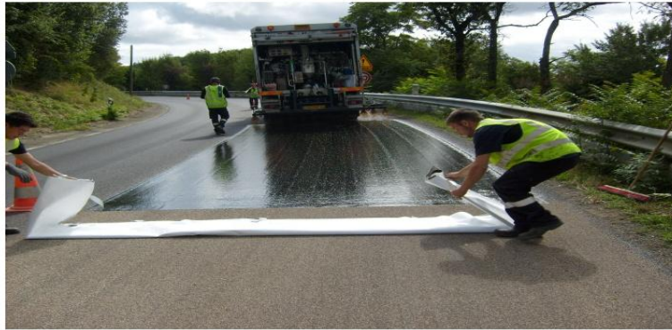
Figure 2 : épandage de la résine EPOXY
