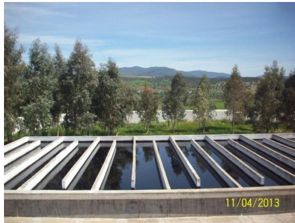
Figure 13: Exemple de bassin de désinfection. (Source STEP de Guelma).
