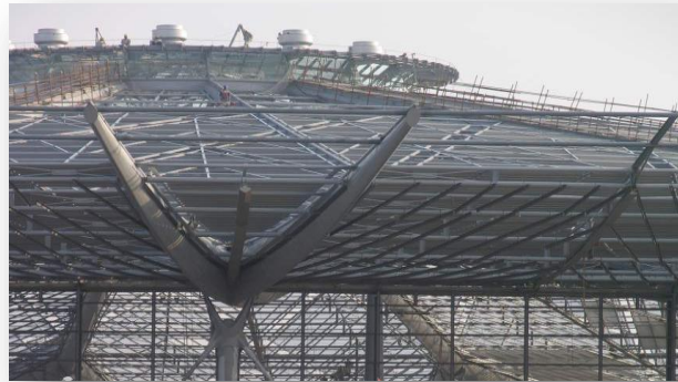
Figure 37 : le volume de la gare de Shanghai-Sud
