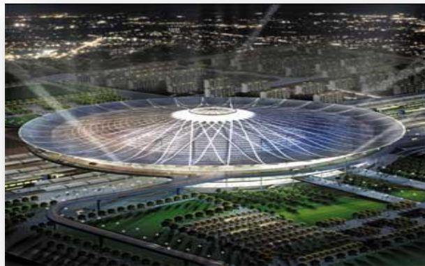
Figure 36 : La gare de Shanghai-Sud
