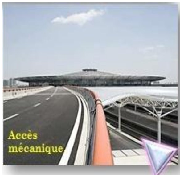
Figure 45 : accès mécanique de la gare
