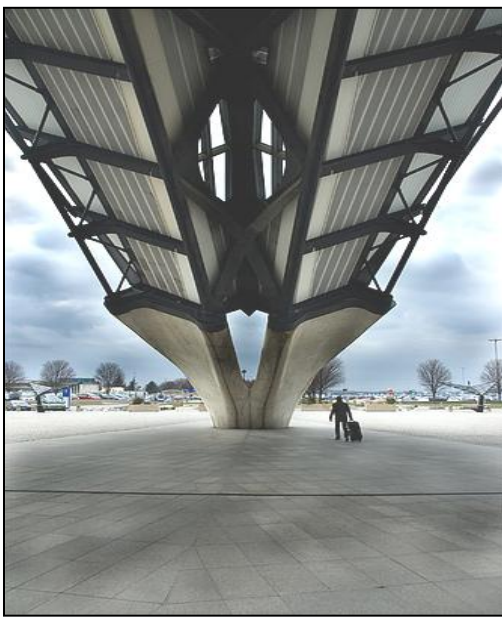
Figure 30 : gare de Satolas
