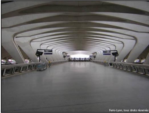
Figure 26 : Passerelle de Satolas
