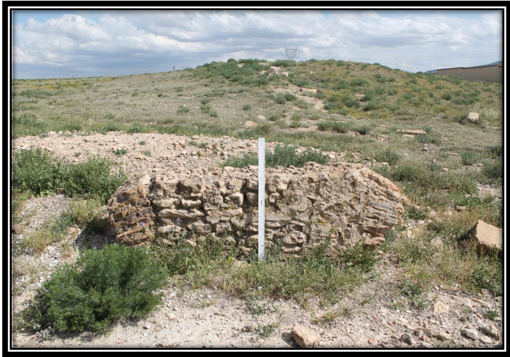
صورة رقم: 12 بغاي جناح من الحمام بداخل الموقع و استعمال التقنية القائمة على صفوف من الأجر
