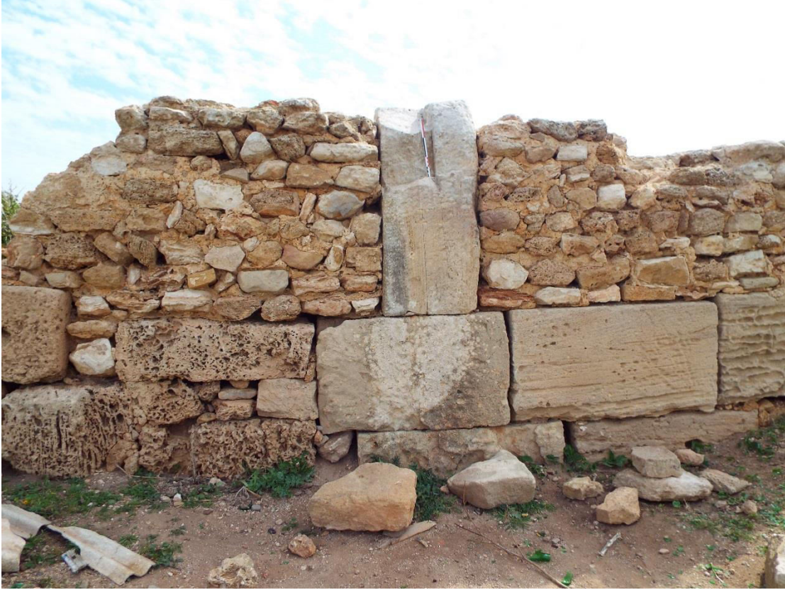
الصورة رقم 02 : جدار الجهة الشرقية
