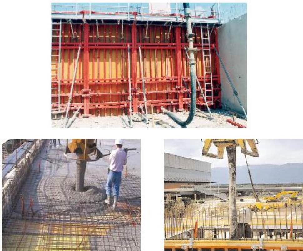
Figure II.15: Mise en place aisée de BAP par un seul ouvrier : au moyen d'une benne dans le cas d'une dalle ou d'une benne munie d'un tube dans le cas d'un mur.
