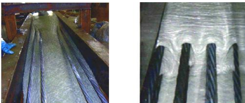
Figure II.16 : Coulage Autoplaçant (béton précontraint)
