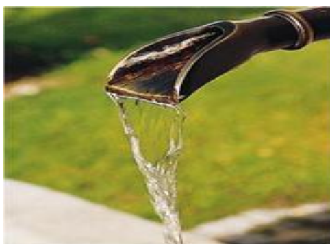
Figure III.2 : L'eau potable convient comme eau de gâchage
