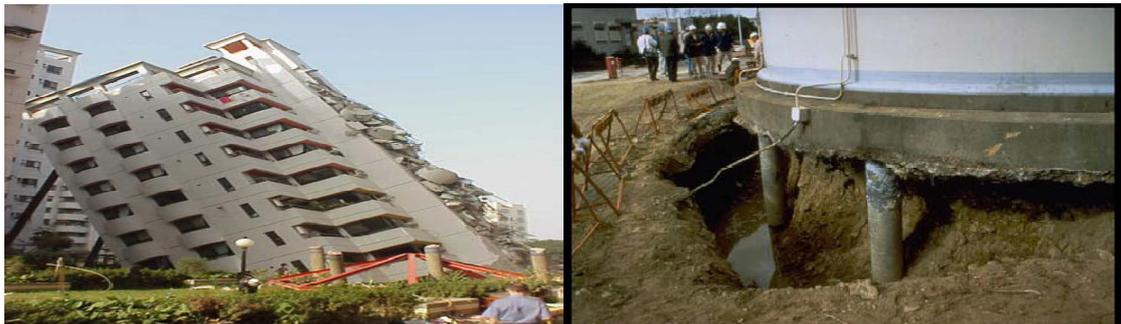
**FIG III. 11** Tassement d'une construction
