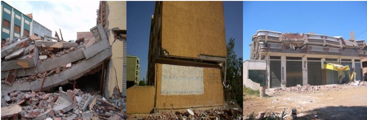
**FIG II.7** Impactes Des Etages Flexibles
