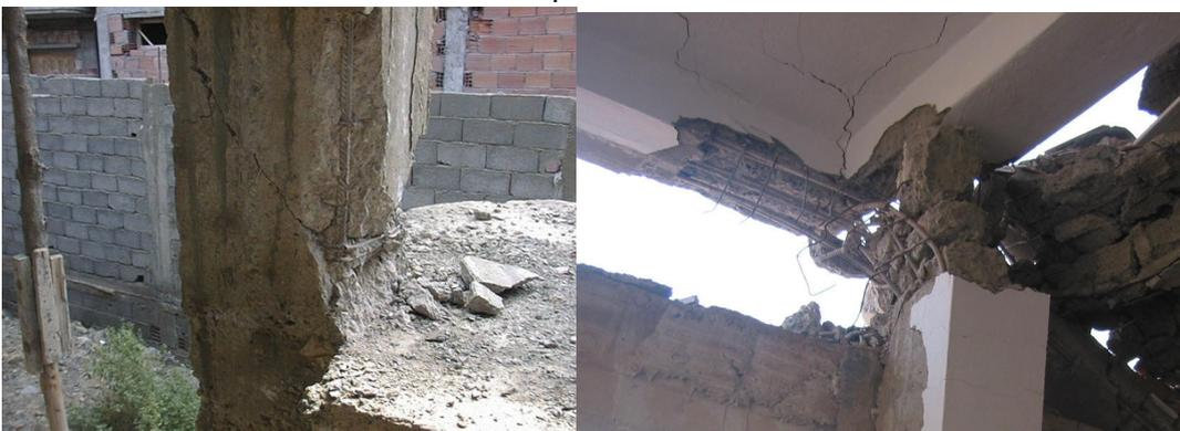
**FIG II.5** Endommagement A Cause D'absence Des Armatures Transversales
