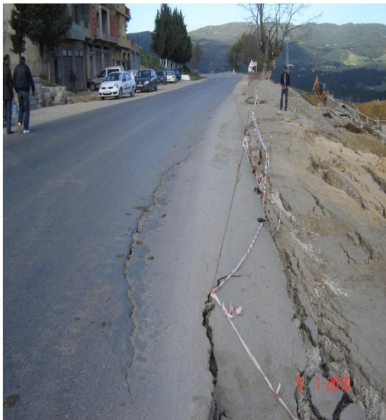
Photo (II.2) : Affaissement et glissement du remblai routier, gessière de sécurité inclinée par le mouvement
