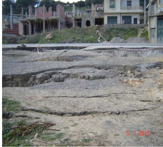
Photo (II.3) : écoulement des eaux à travers le talus
