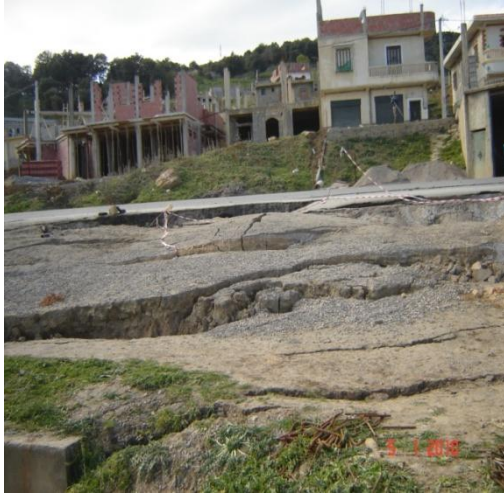
Photo (II.3) : écoulement des eaux à travers le talus
