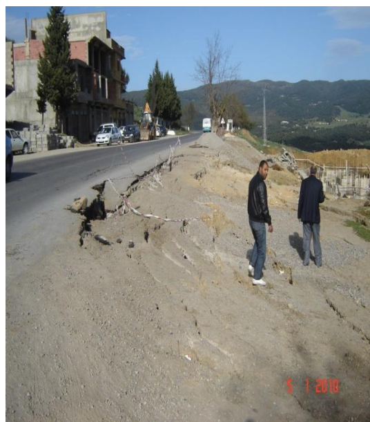
Photo (II.2) : Affaissement et glissement du remblai routier, gessière de sécurité inclinée par le mouvement
