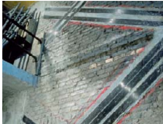
Fig. 1.24. Réhabilitation d'un mur en maçonnerie (Suisse) [NET 01]
