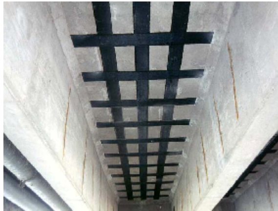
Fig. 1.25 Renforcement d'une dalle de pont [K]
