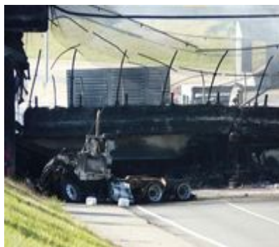
Fig. I.3 : Choc sur une pile de pont
