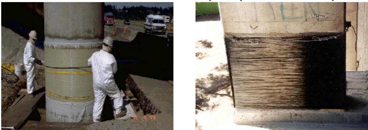
Fig. 1.23. Confinement de colonnes de ponts par matériaux composites [K]
