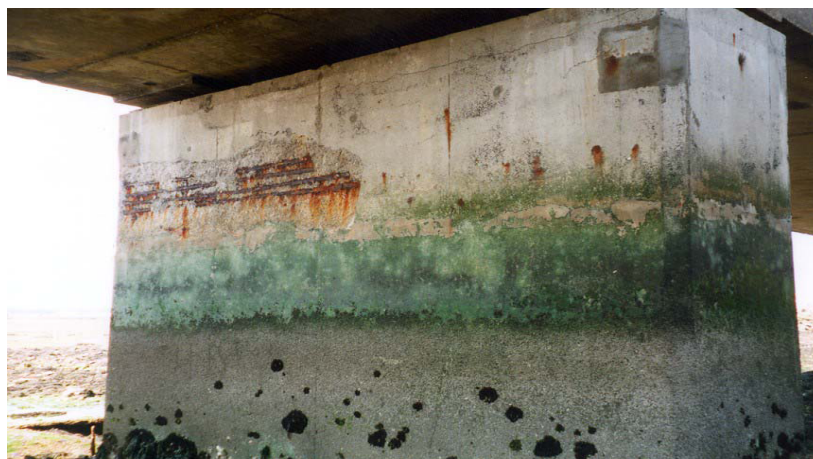
Fig.I.18 : Pile en zone de marnag[Net01].
