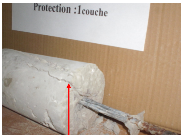
Fissure tout le long de l'ancrage
