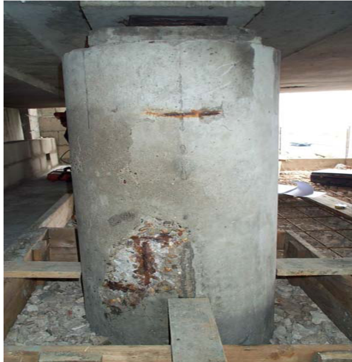
Fig I.16 : Pile de pont[Net01].
