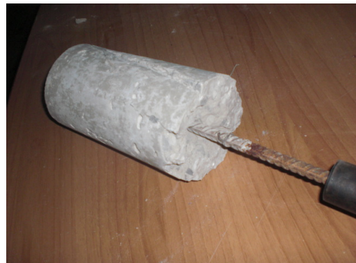
Enlèvement d'un petit cône de béton
