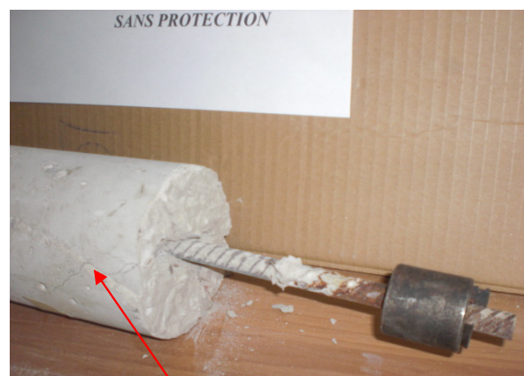
Fissure très fine le long de la masse de béton
