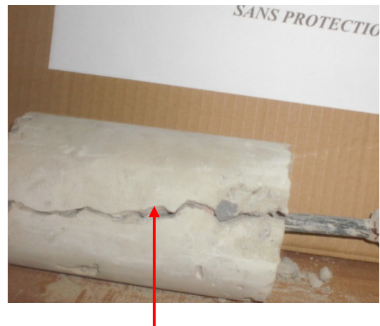
Fissure profonde et épaisse
