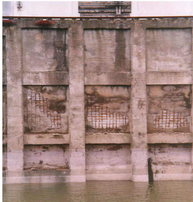
Fig. I.20 : Quai en zone de marnage[Net02].
