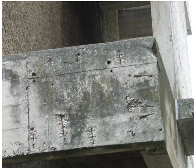
Fig. I.22: Parement en béton armé[Net02].
