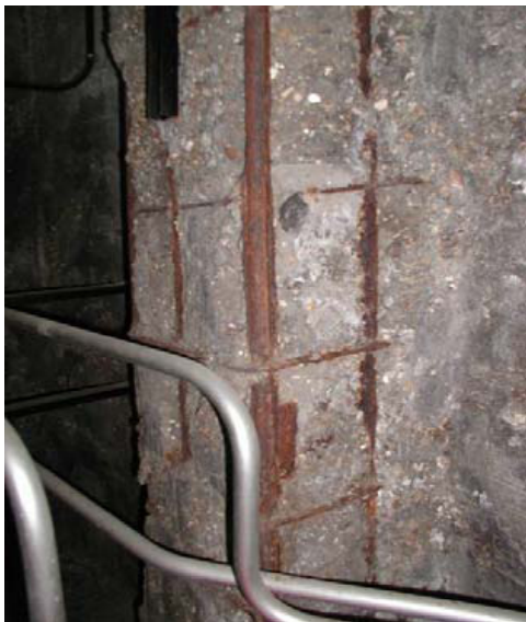
Fig. I.14-: Poteau porteur sous garage
