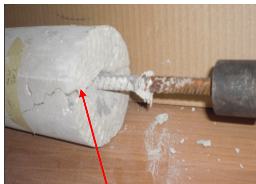
Fissure profonde le long de l'ancrage
