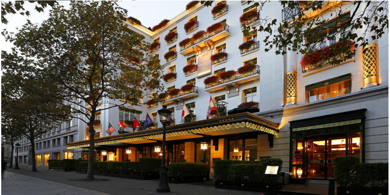
Figure 13:L'Hôtel Napoléon à Paris ,source : en ligne https://fr.hotels.com/ho110405/hotel-napoleon-paris-france/ grâce à l'utilisation du système d'automatisation de protections solaires (à l'extérieur
