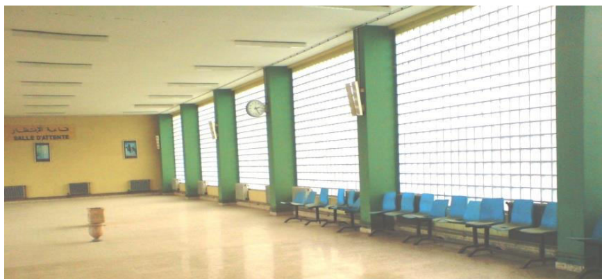
Fig104: Salle d'attente; grande hauteur; structure poteau-poutre.
