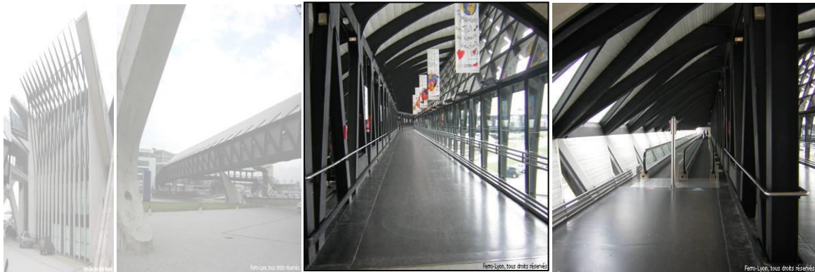
Fig70: les passerelles de la gare
