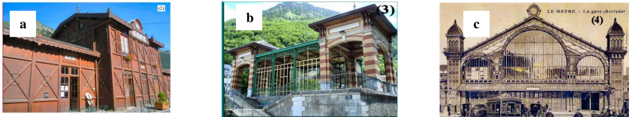
Fig. 20 : le bâtiment voyageur
