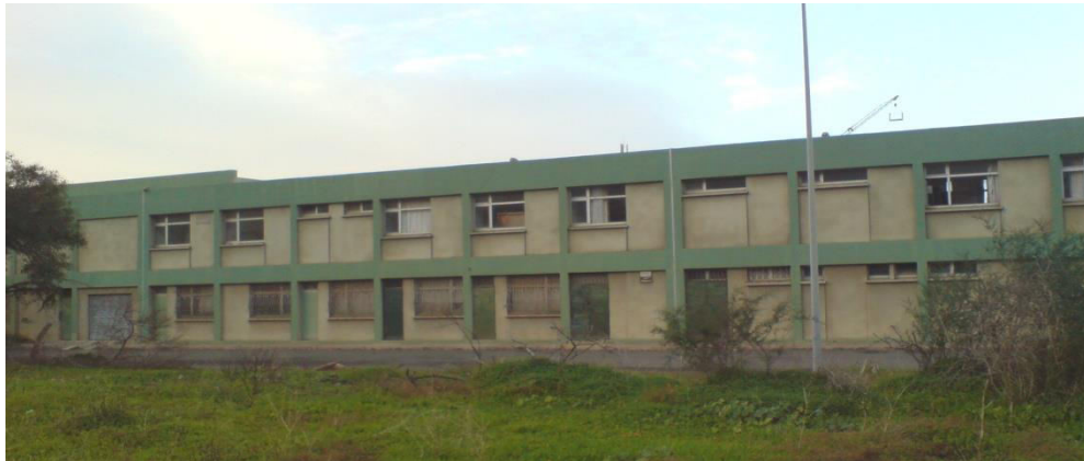
Fig102 : Vue sur les locaux techniques.
