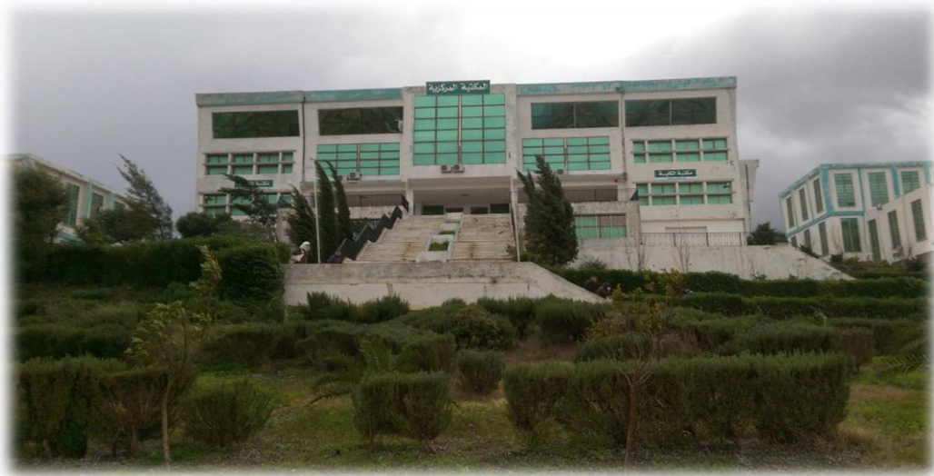
Figure 53: façade principale de la bibliothèque (source : auteur)
