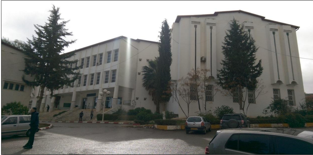
Figure 59: vue sur la façade Nord (source : auteur)
