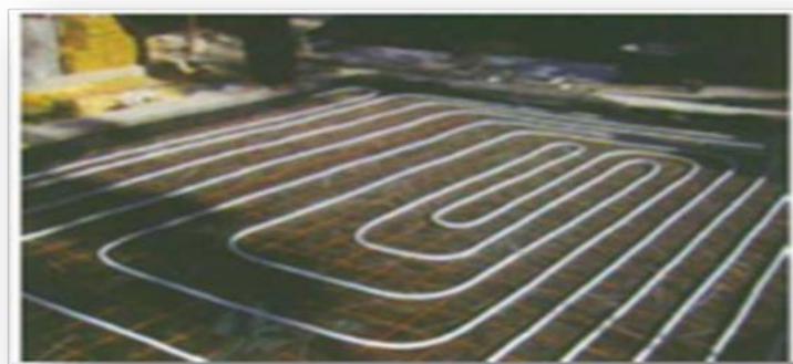
Fig. 32 : plancher chauffant.
