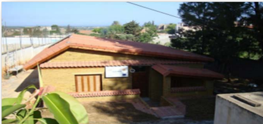
Fig. 26 : façade de Soudania. Source : Projet MEDA (MED-ENEC), www.aprue.org.dz ,
