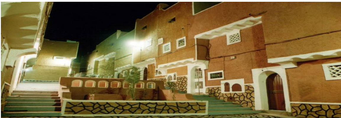
Figure 27: l'état du cadre bâti. (Source : http://tafilelt.com/site )
