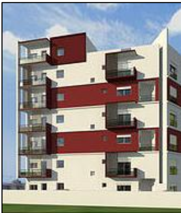
Figure 58 : Façade Nord du bloc E, (Source : bessapromotion.com)
