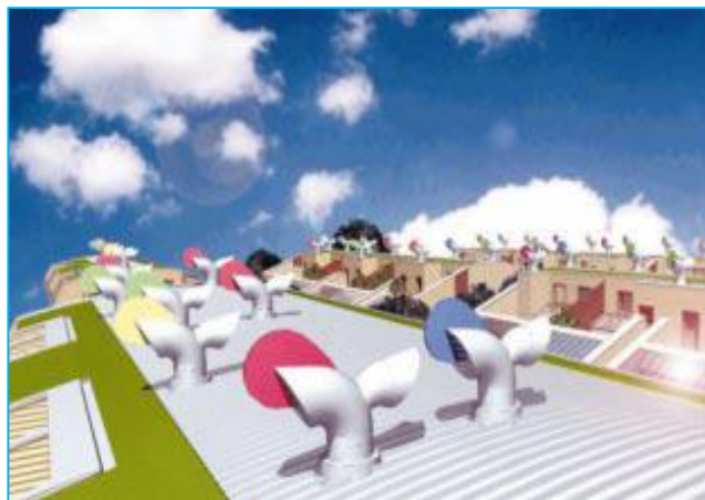
Figure 22 Système de ventilation naturelle par conduite d'air.
