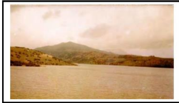
figure 72: Barrage de Medjaz El Bgar
