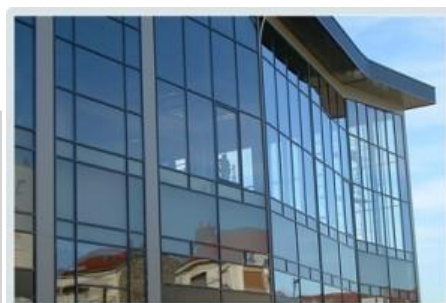
FIGURE 19: VITRAGE EXTÉRIEUR COLLÉ (VEC)
