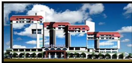
Figure 84 : façade principale du centre d'affaire.
