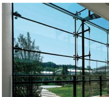
FIGURE 17 : VITRAGE EXTÉRIEUR ATTACHÉ (VEA) SOURCE ( HTTP://FECAMP-SERVICES.COM/BLOG/FACADES-VITREES )
