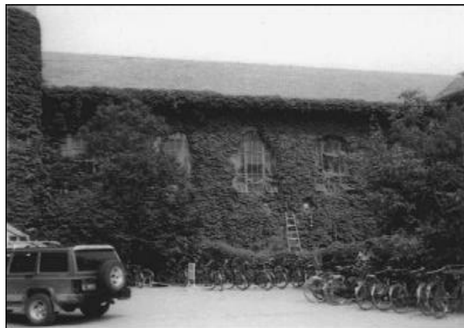
Figure 12 Vue Ouest de la bibliothèque d'université de Tsinghua
