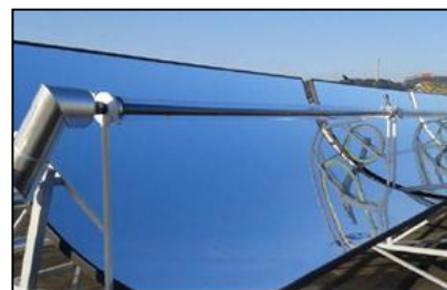
Figure 32: Les capteurs cylindro-parabolique. Source : GIZ/ Michael Netzhammer.
