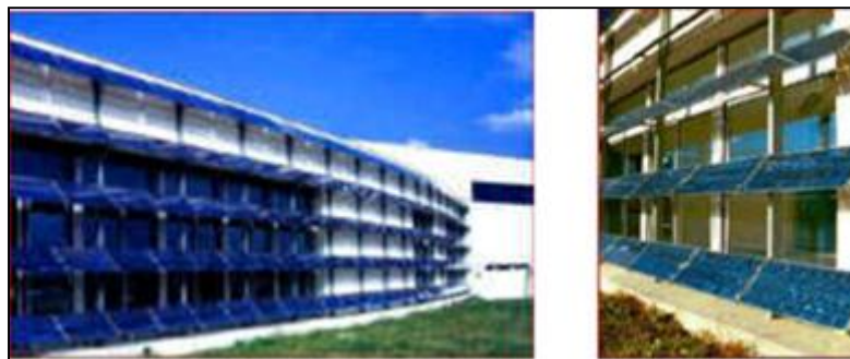
Figure 44: Les capteurs solaires en brise soleil
