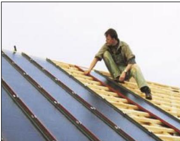
Figure 40: Intégration des capteurs en toiture inclinée.
