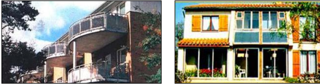
Figure 43: Les capteurs solaires en garde-corps et en allège.
