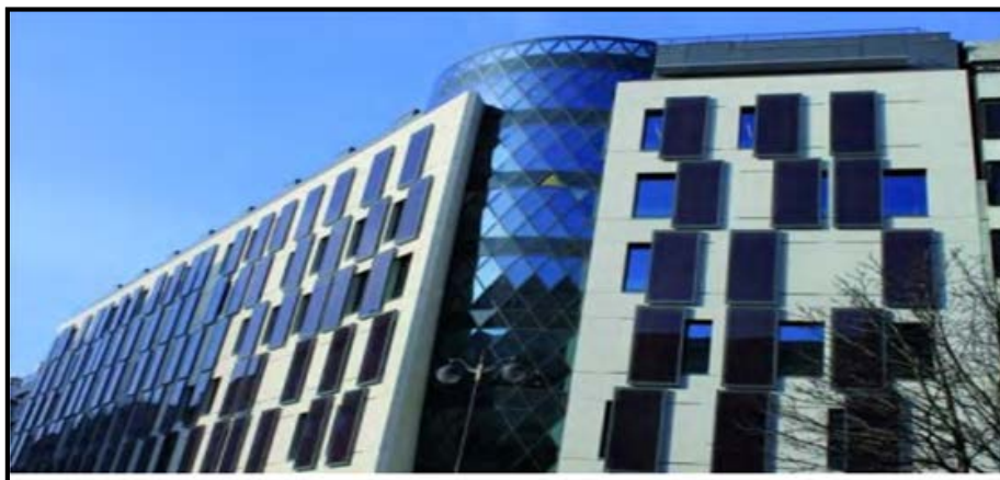
Figure 37: La façade est dotée de volets coulissants motorisés en panneaux photovoltaïques.
