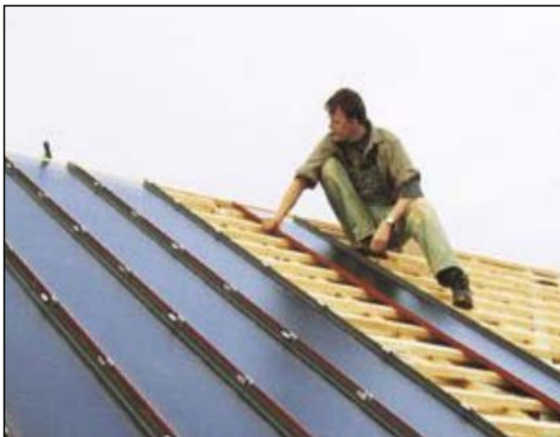
Figure 40: Intégration des capteurs en toiture inclinée.
