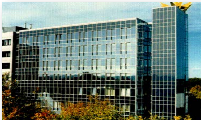
Figure 42: Intégrations des capteurs en façade.
