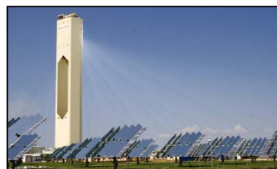
Figure 31: Le central à tour. Source : GIZ/ Michael Netzhammer.
