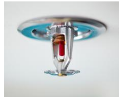
Figure N° 16 : système sprinkler Source : http://fr.wikipedia.org/wiki/sprinkler
