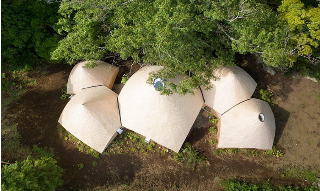
Figure N° 35 : vue aérienne « Issei Suma» Source : http://www.designboom.com/ Février 2017
