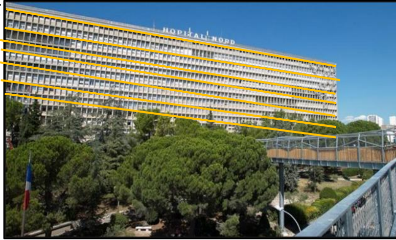
Figure 68 :la façade principale de l'hôpital de nord (source : Google image)
