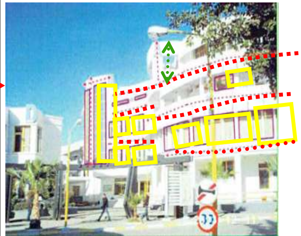
Figure 72 : Façade principale Bloc A et B.
