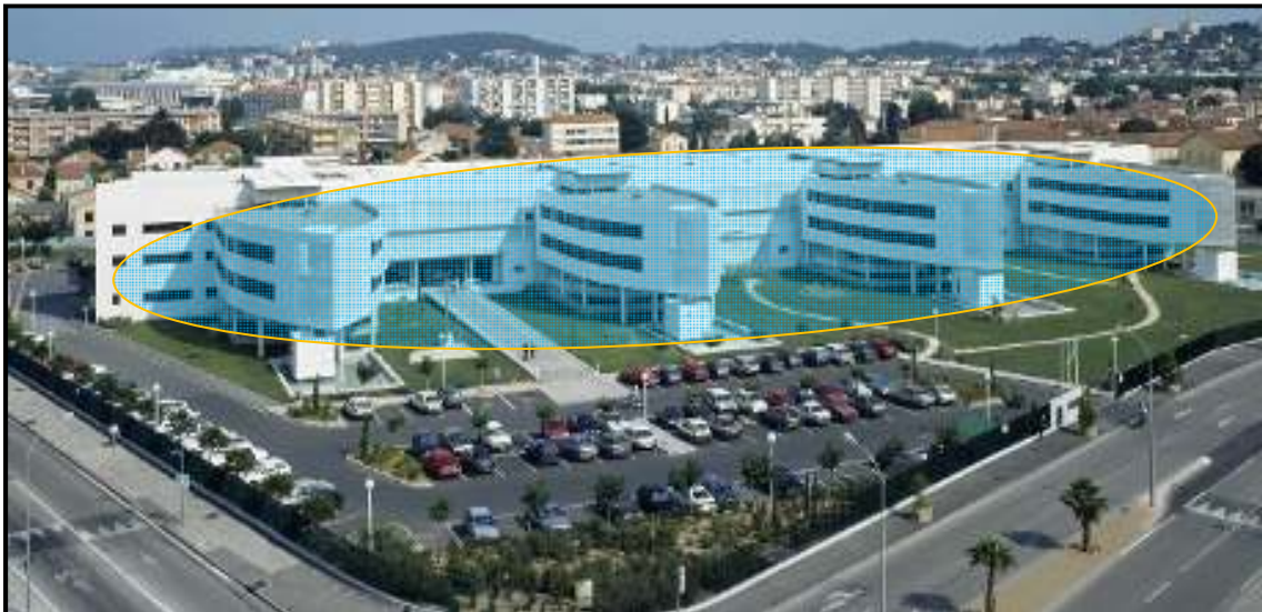
Figure 103 La façade (Source : bbg architectes sante/hôpital-la-Seyne-sur-mer 2018).
