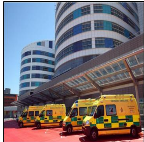
Figure 30; photos illustre la façade postérieur de l'hôpital.
