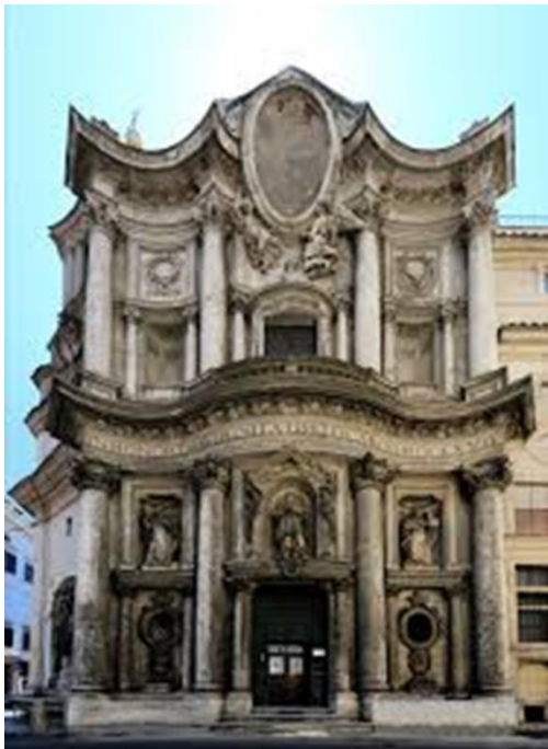
Figure II.1 : San Carlogo FourFontane Source : https://www.alamyimages.fr/l-art-baroque-l-italie-rome-l-eglise-de-saint-charles-des-quatre-fontaines-1634-par-francesco-borromini-1599-1667-facade-image209609612 .
