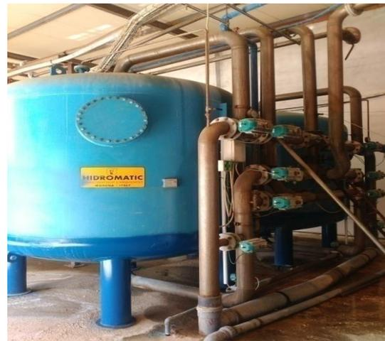
**Figure 5** : Filtres à sable de 2400 m<sup>3</sup>
