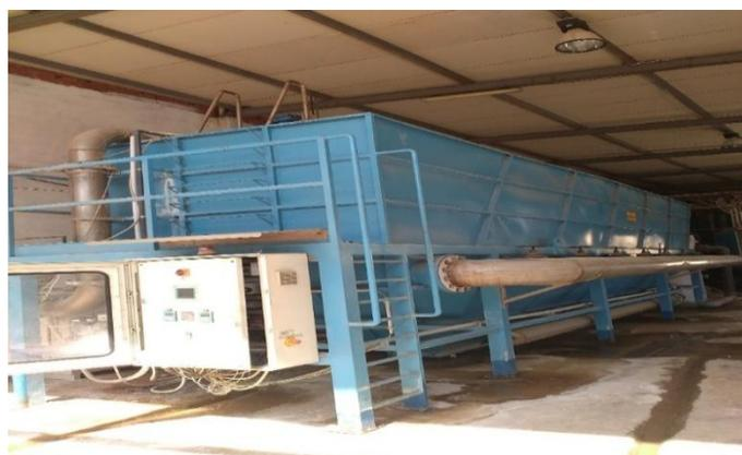
**Figure 3** : Décanteur «Bassin de la floculation-coagulation » (CAB, 2017).
