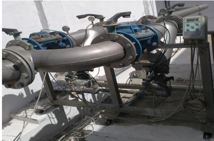
**Figure 2** : Filtre autonettoyant (CAB, 2017).
