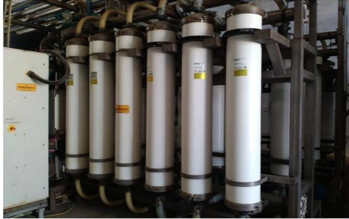
**Figure 6** : Appareille de l'ultrafiltration (CAB, 2017).
