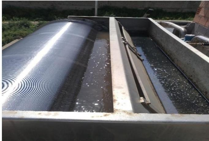
**Figure9** : filtre dégrilleur (CAB, 2017).
