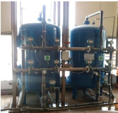
**Figure 4** : Filtres à sable de 1200 m<sup>3</sup>
