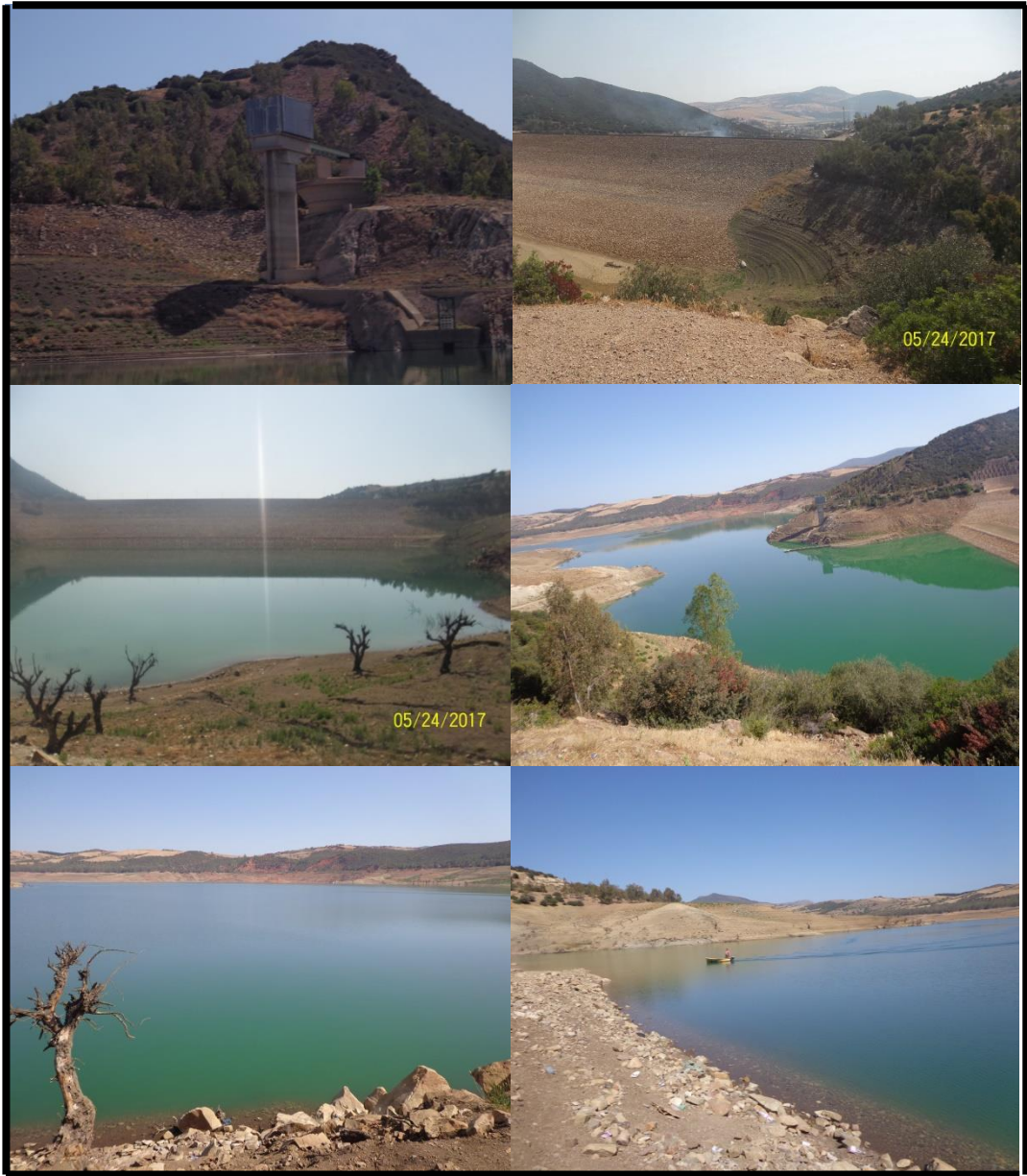
Annexe 1: Photos du Barrage de Bouhamdane (24/05/2017)
