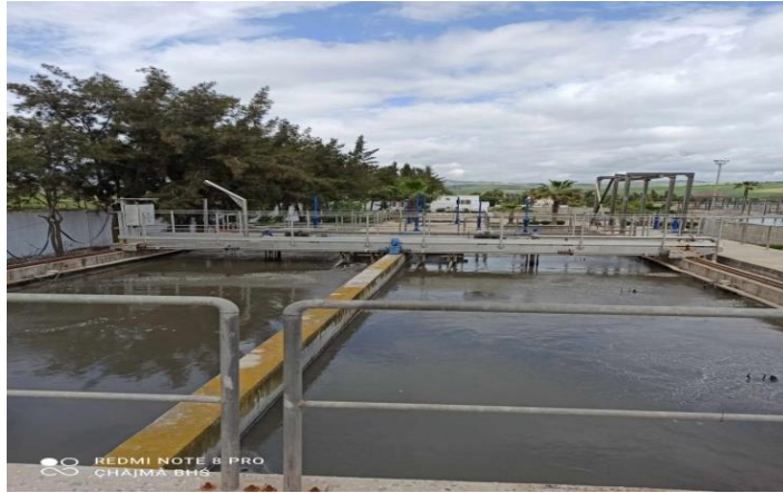
Figure I.4 : Dégraissage – Déshuilage
