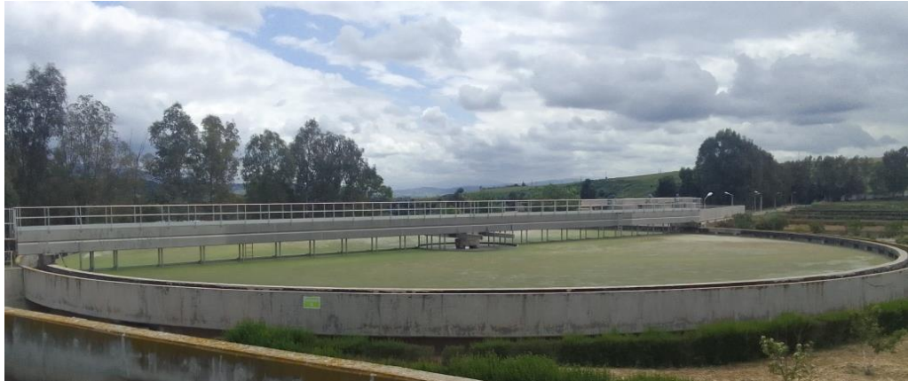
Figure I.8 : stabilisation des boues.
