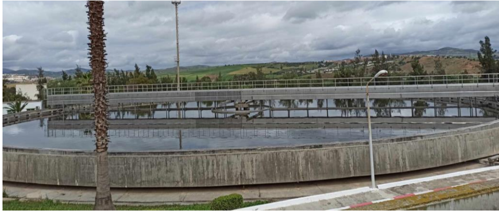
Figure I.5 : Décantation primaire
