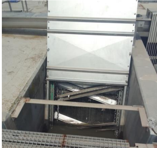
Figure I.2 : Dégrillage
