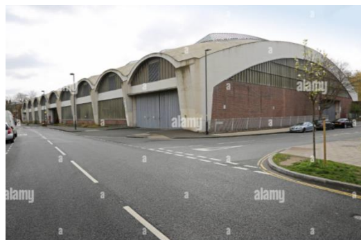
Figure 6: Stockwell Bus Garage, dans le sud de Londres [9]
