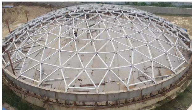
Figure 42: Toit à dôme en aluminium [76].
