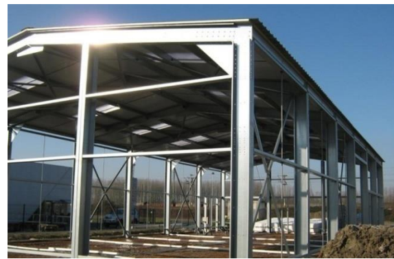
Figure 22: Charpente métallique d'un hangar [29].
