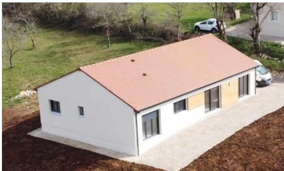
Figure 27: Toit à deux pans [33].
