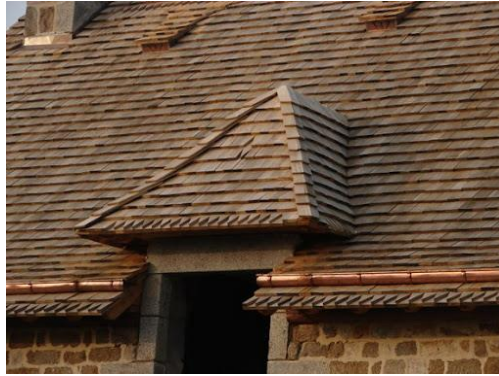
Figure 16: Toit avec des bardeaux en bois [23].
