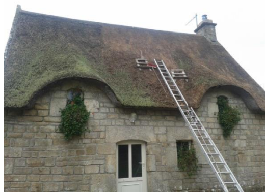
Figure 23: Toit en chaume [30].
