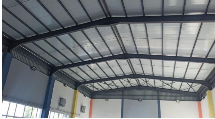
Figure 13: Toiture en charpente métallique- la nouvelle piscine semi olympique - Guelma-
