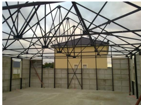
Figure 11: Toit avec fermettes en charpente métallique [18].
