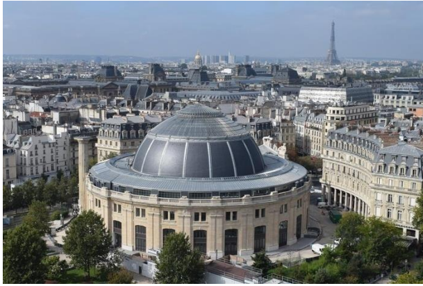
Figure 43: Toit à dôme en aluminium [78].
