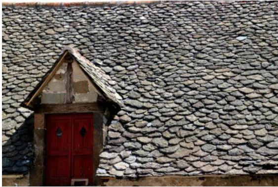
Figure 24: Toit en pierre lauze [25].
