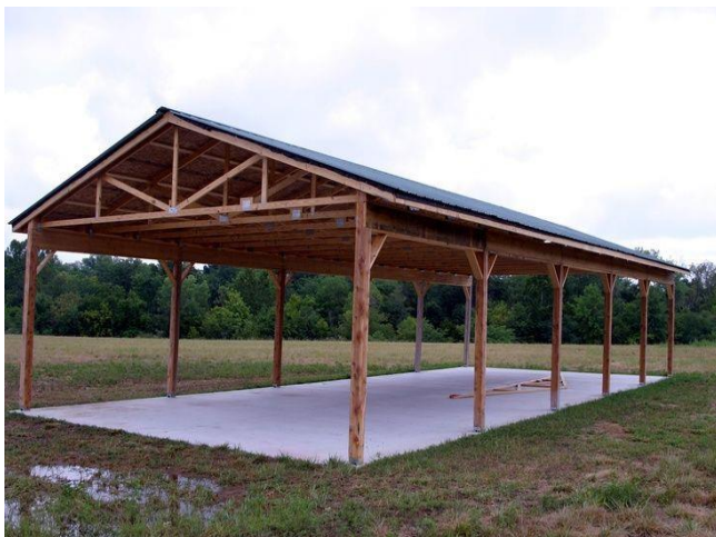
Figure 7: Ferme avec charpente en bois industriel [12]
