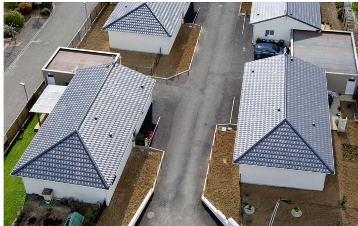
Figure 37: Des constructions avec toit à trois pans [53].
