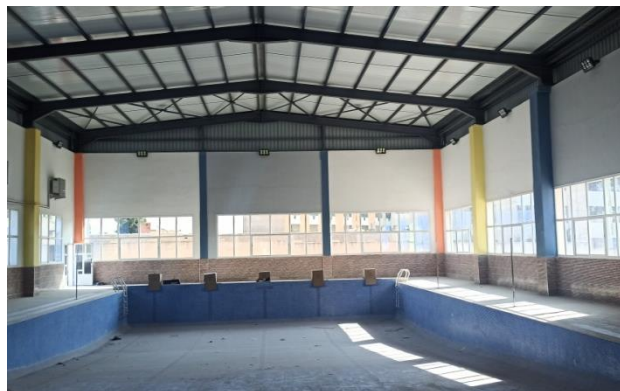
Figure 12: Toiture en charpente métallique- la nouvelle piscine semi olympique - Guelma-
