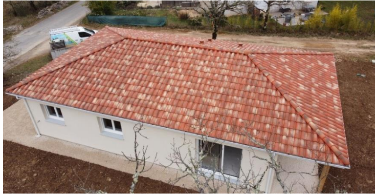
Figure 32: Toiture à quatre pans [36].
