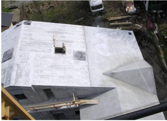
Figure 4: Réalisation d'une maison avec toiture en béton [8]
