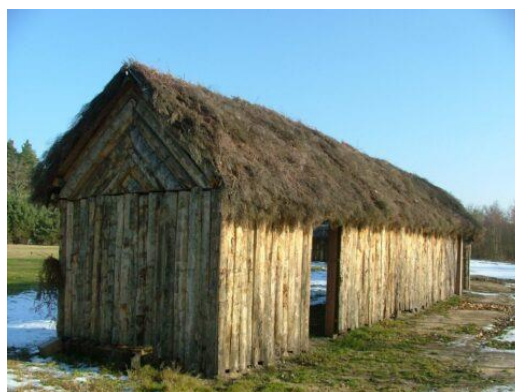
Figure 18: Toiture en brande de bruyère [25].
