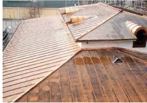
Figure 20: Toiture en cuivre [27].
