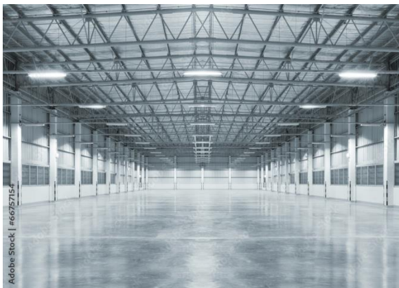
Figure 10: entrepôt en charpente métallique (acier) [17]
