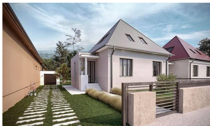
Figure 33: Toiture en pavillon [37]
