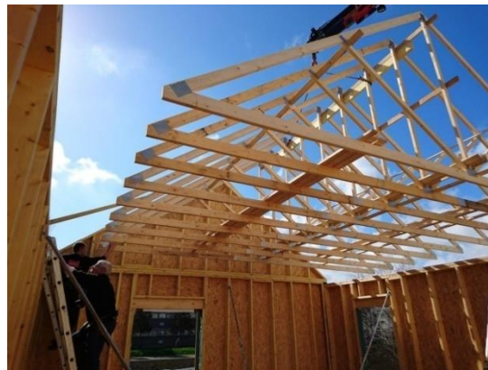
Figure 9: Structure en charpente fermette en bois [14]
