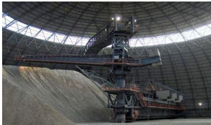
Figure I.5 : Hall de pré-homogénéisation
