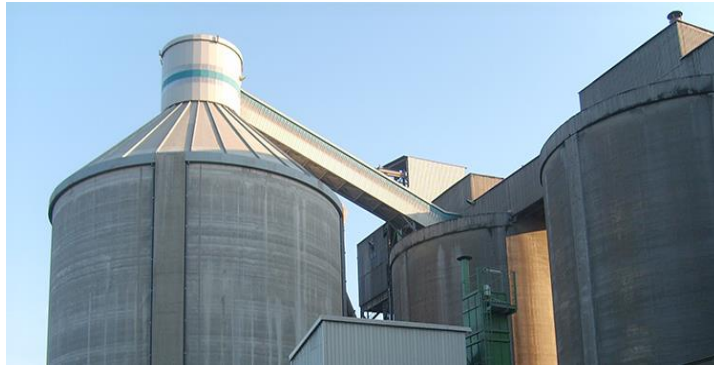
Figure I.8 : Silo de stockage du clinker
