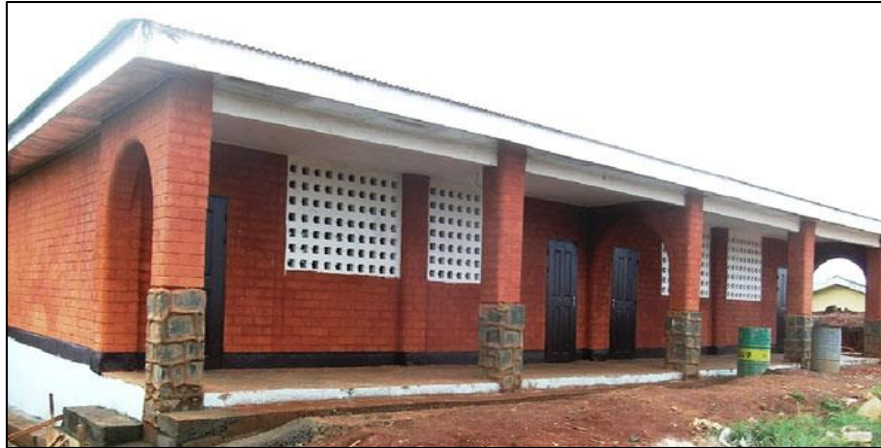
Figure I.6 : Blocs de terre comprimée.
