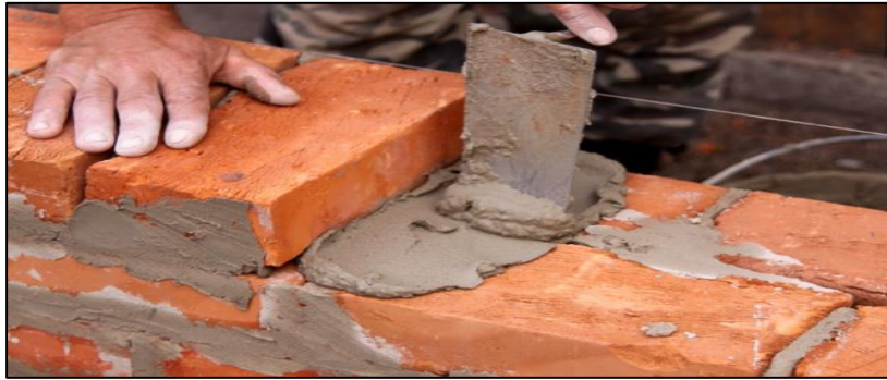
Figure II.6 : Joints de maçonnerie.
