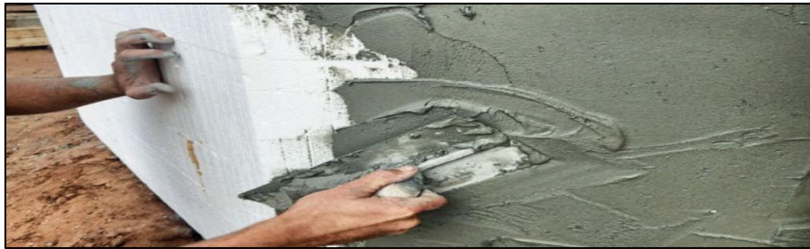
Figure II.7 : Application d'enduit.
