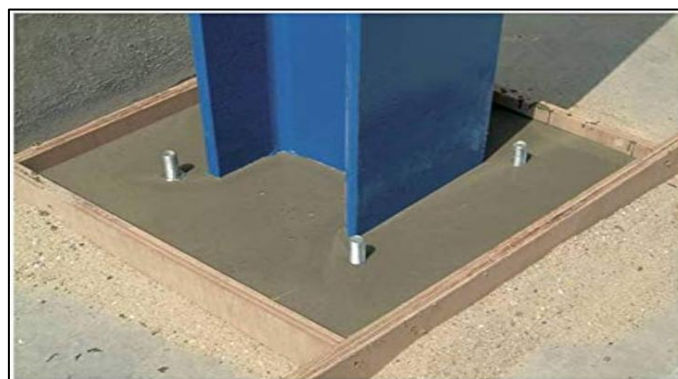
Figure II.8 : Calage d'un poteau en charpente métallique.
