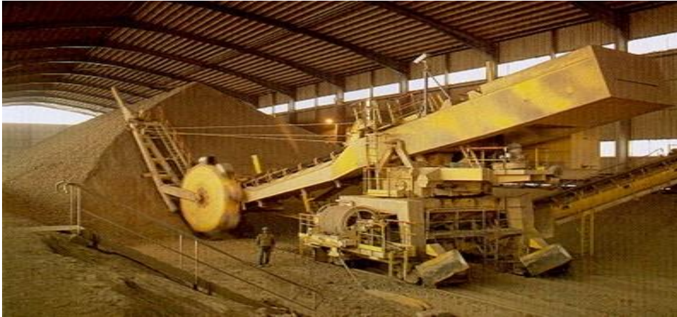
Figure I. 5: Hall de préhomogénéisation du cru [24]
