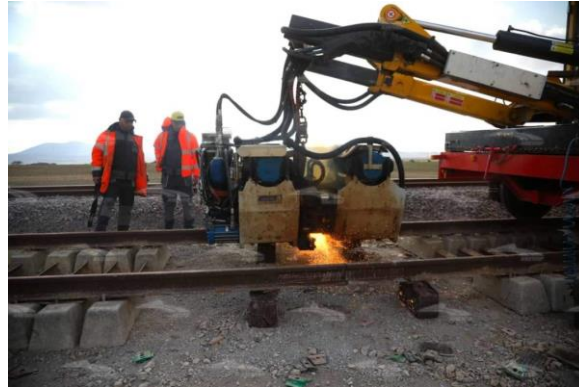
Figure VI. 6: Soudure électrique des LRS
