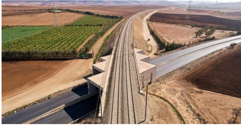
Figure IV. 5: Passage inférieur de la route [2]
