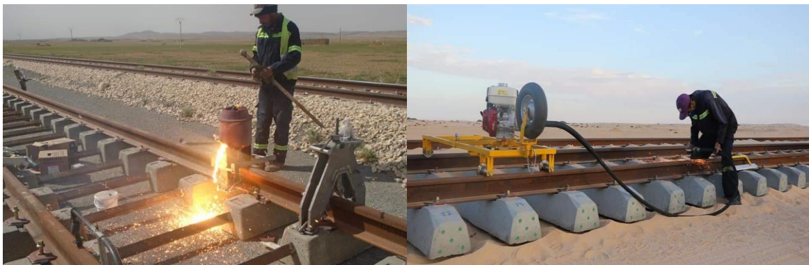
Figure VI. 7: Soudure des LRS
