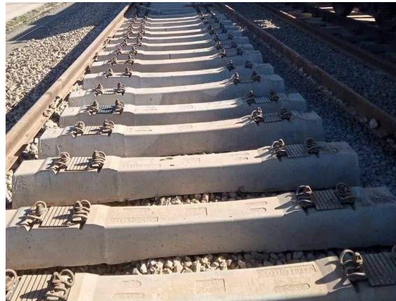
Figure VI. 14: traverse béton armé Monobloc [21]
