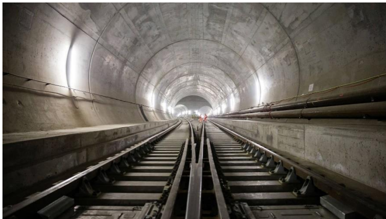
Figure IV. 6: Passage ferroviaire souterrain (tunnel saint Gothard -Suisse)
