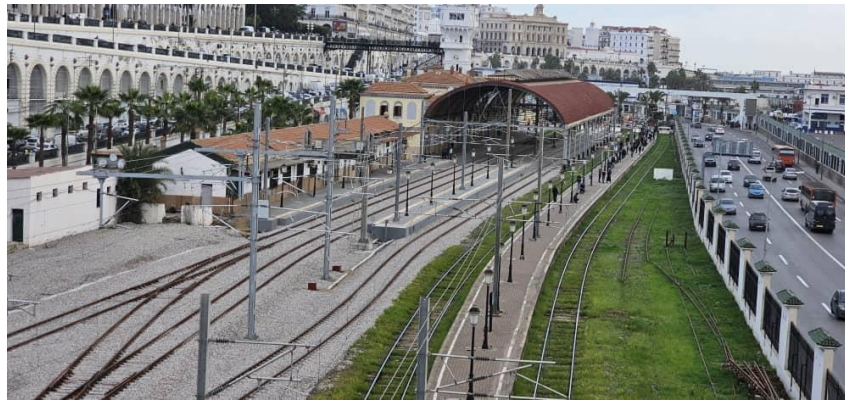
Figure VII. 3: Gare terminus d'Alger
