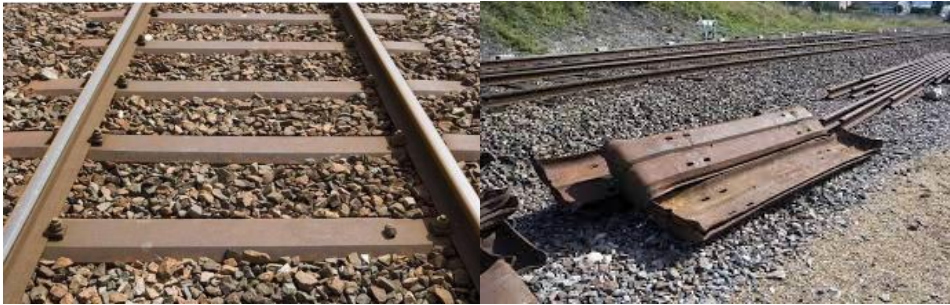
Figure VI. 12: Travers métalliques [21]
