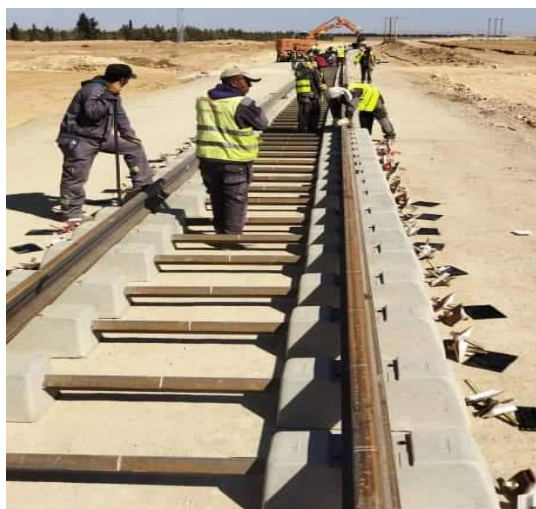
Figure VI. 13: Travers en béton armé Bibloc [21]
