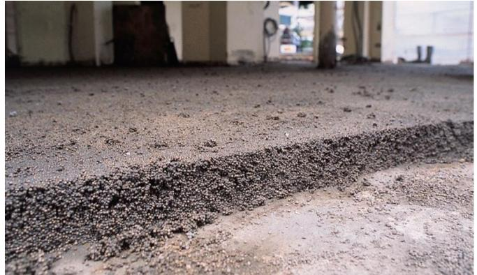
Chape en béton léger de polystyrène
