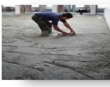
**Photo II.3** : béton de polystyrène expansé
