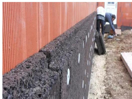
**Photo I.22** : Isolation avec liège expansé et naturel
