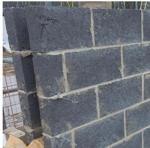
Mur extérieur en bloc plein de béton de granulats légers
