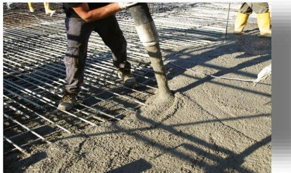
**Photo II.1** : béton de granulats légers
