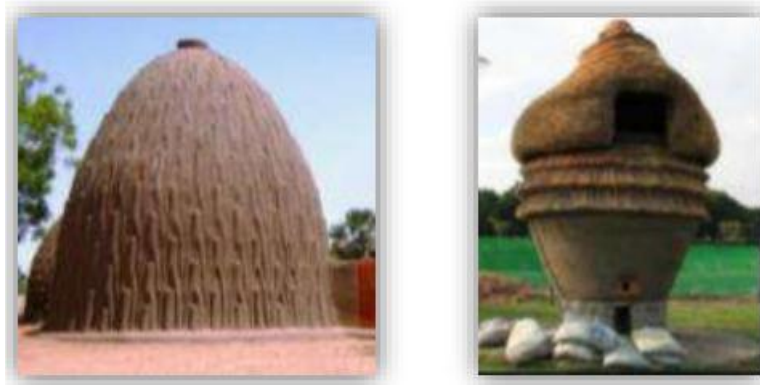
Figure II. 12 Construction En Terre Façonnée. [18]
