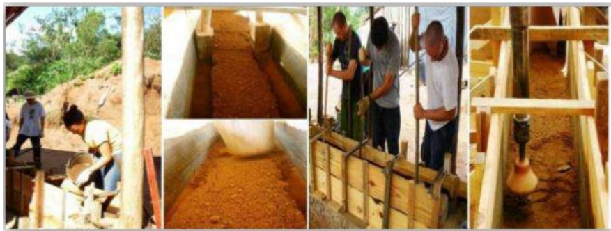
Figure II. 6 Les Etapes De Construire Un Mur En Pisé
