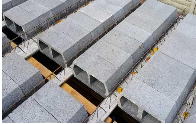
Figure I. 4: Plancher à corps creux
