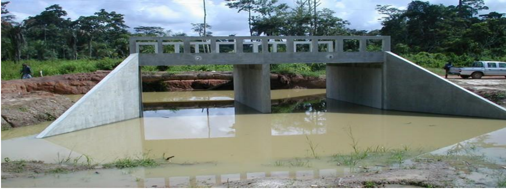
Figure I.1 : Ouvrage en dalot d'eau.
