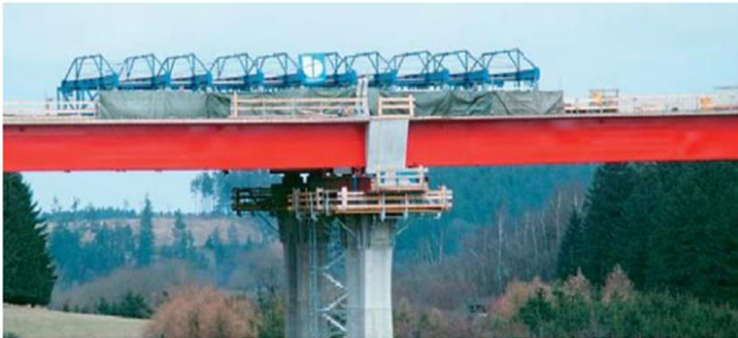
Figure II.6 : Tablier d'un pont construit par cintre.
