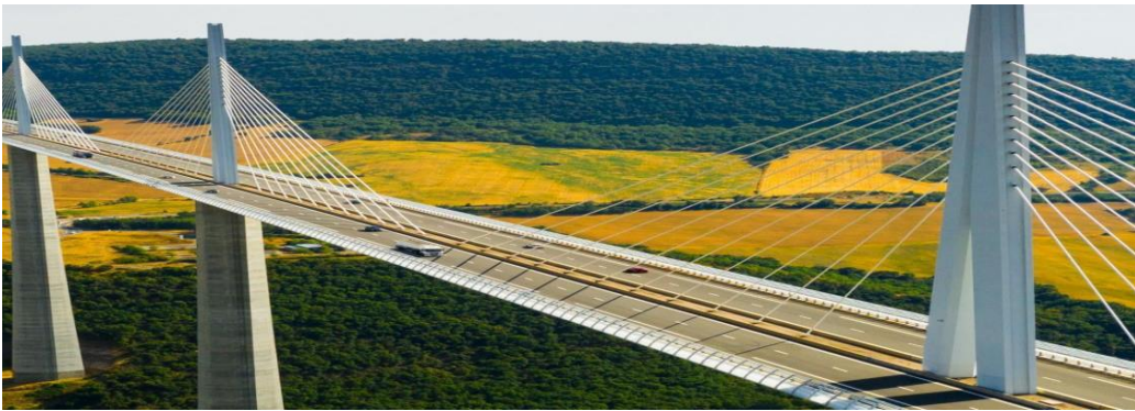
Figure I.2 : Viaduc de Millau.
