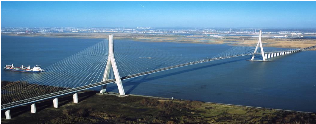
Figure I.3 : Viaducs d'accès au pont à haubans de Normandie.
