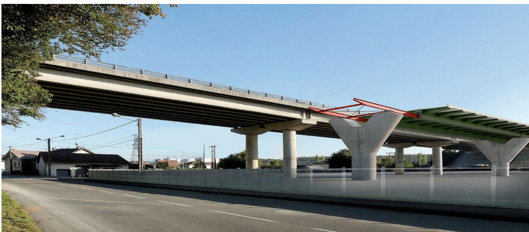
Figure II.5 : Tablier d'un pont par la méthode de poussage.
