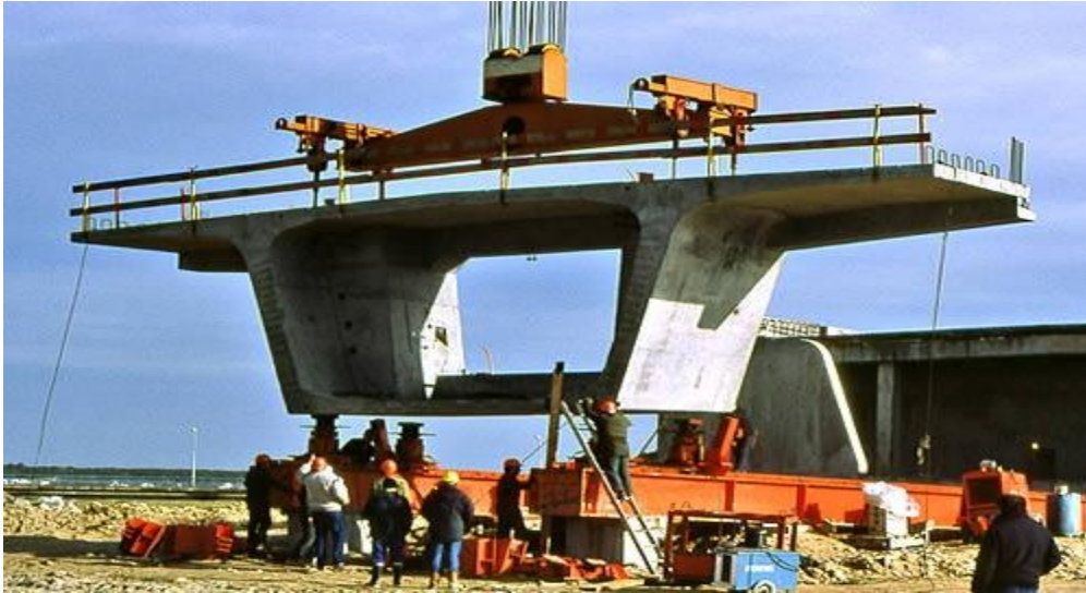
FigureII.3 : Pont a poutre en caisson(voussoir).
