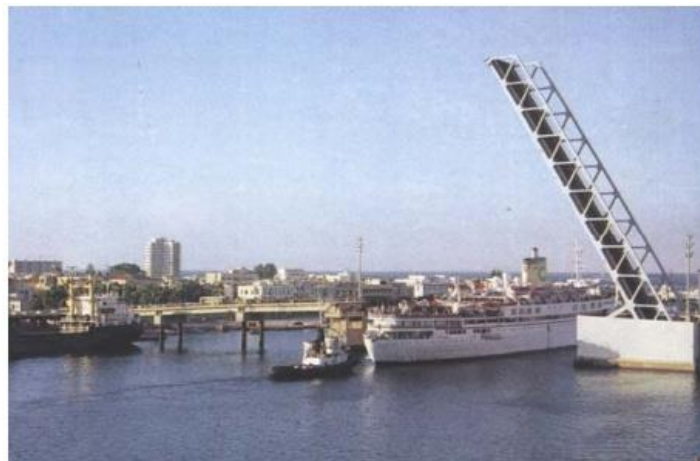
Figure I.24 : Pont Basculant de Bizerte, Tunisie, construit en 1980.
