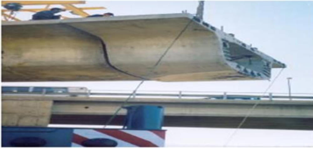
Figure II.7 : Tablier d'un pont construit par encorbellement.
