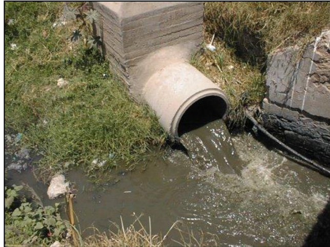
Figure 01 : Exemple d'un rejet des eaux usées (Bengouga, 2010).
