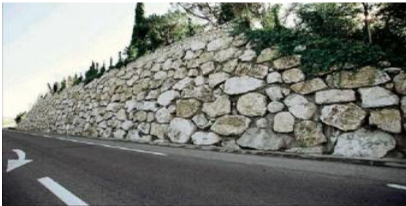
Figure 1. 2: Mur en maçonnerie jointoyée
