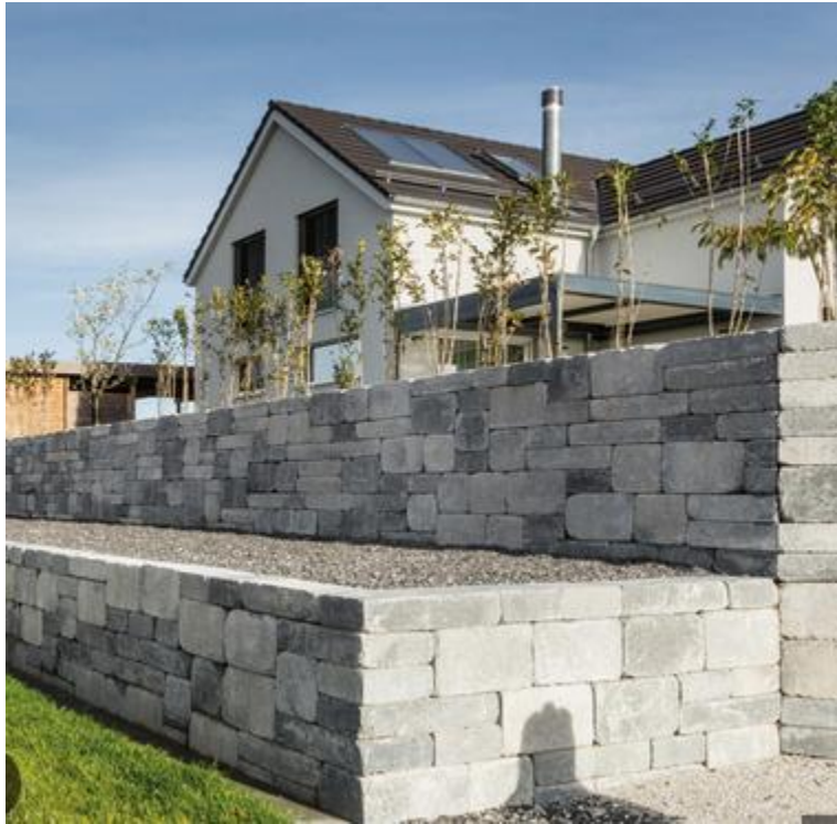
Figure 1. 5: Mur en élément préfabriqués
