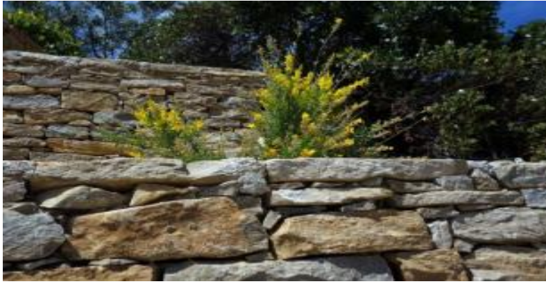
Figure 1. 1: Mur en maçonnerie de pierrées sèches
