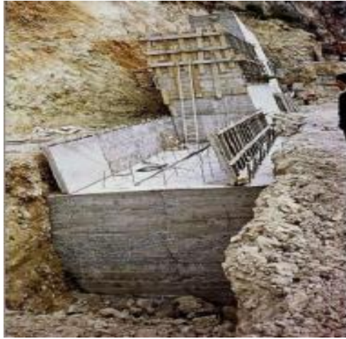
Figure 1. 3: Mur poids en béton
