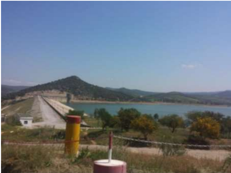
Fig.3.1. Photo du barrage de Zit-El-Emba
