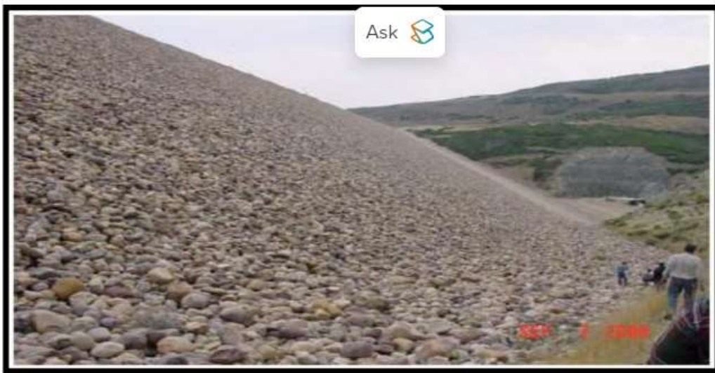
Figure 1.16: protection du talus aval avec des galets dans le barrage de Jordanelle, Utah, USA (USBR, 2012)
