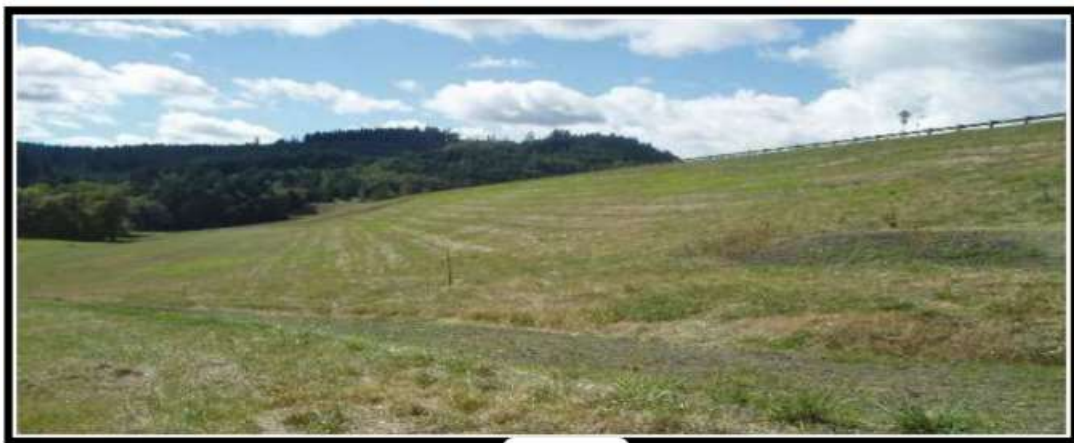
Figure 1.17: protection végétale du talus aval du barrage de Scoggins, Oregon (USBR, 2012)
