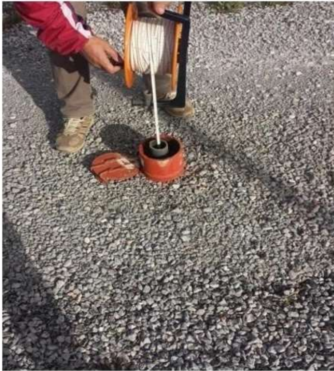
Fig. 3.15 : Photo d'un piézomètre dans le barrage de Zit El Emba
