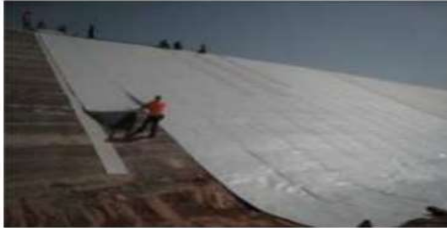
Figure 1.8 : Mise en place du masque de barrage zit El Emba
