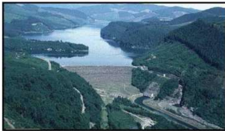
Figure 2.9 : Photo du Barrage de Swift aux USA avant la rupture.
