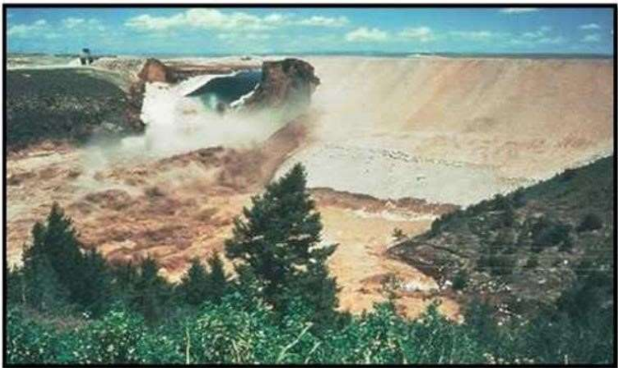
Figure 2.12 : Rupture du barrage de Teton.
