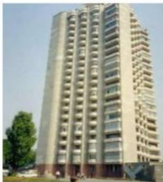
Fig. 1.9 : Premier immeuble en béton géopolymère à Lipetsk, Russie, 1994
