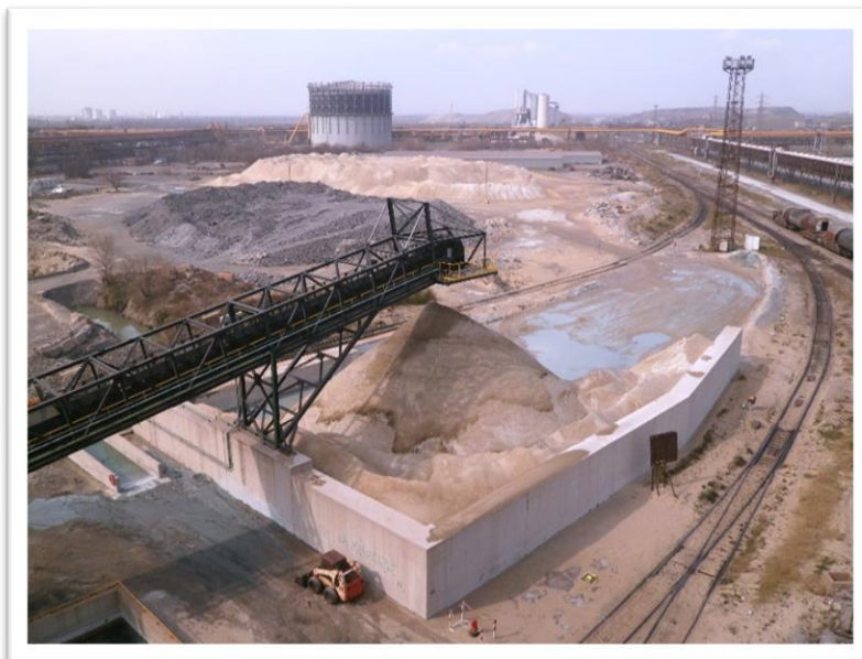
Fig. 1.4 : Tas de laitier de haut fourneau [10]
