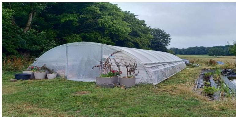
Figure I. 3. Les serres à faible technologie (serre tunnel).
