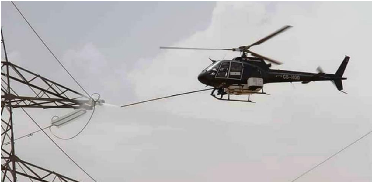
Figure III.6 : Lavage sous tension des isolateurs des lignes haute et très haute tension au profit de la société Sonelgaz dans la ville de Sidi Ali Boussidi - wilaya de Sidi Bel Abbes, Algérie.
