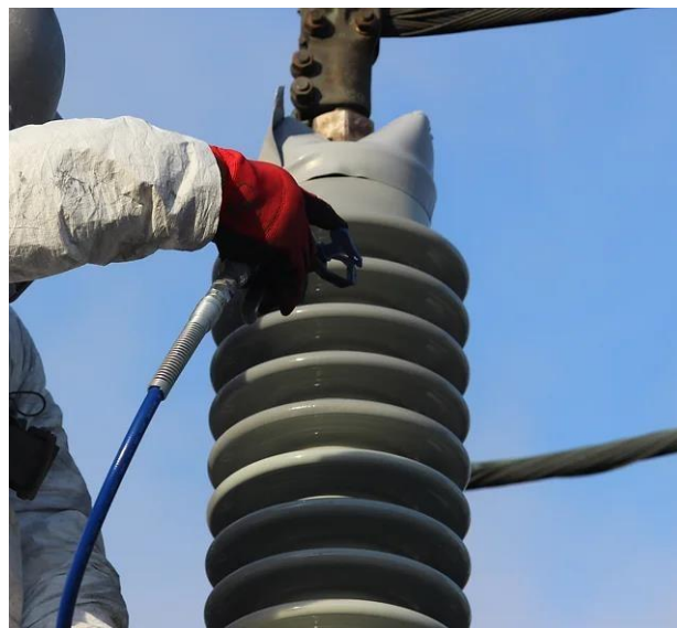
Figure III.3 : Opération de revêtement d'un isolateur.
