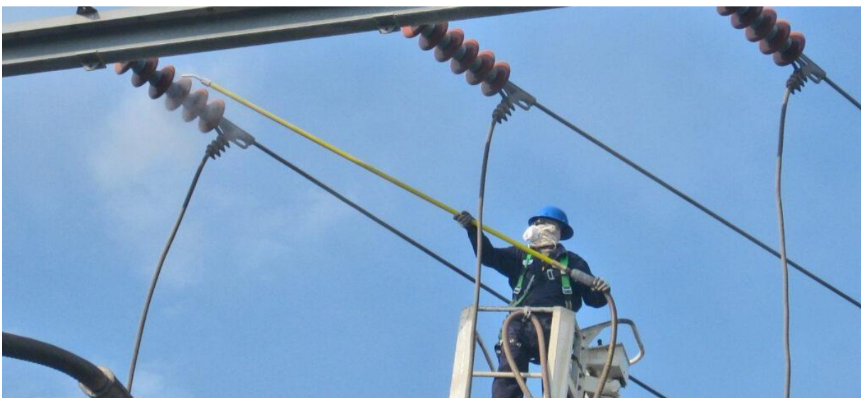
Figure III.5 : Lavage hors tension des isolateurs.
