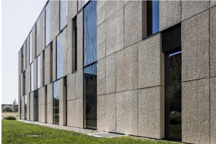
*Figure 20 : la façade en béton armé*
