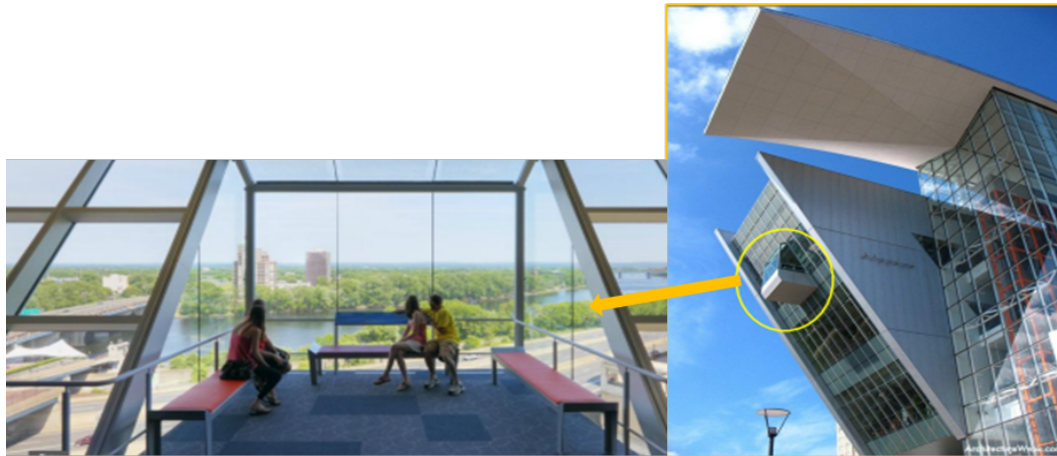
Fig-92 Le mur incliné du bloc Nord
